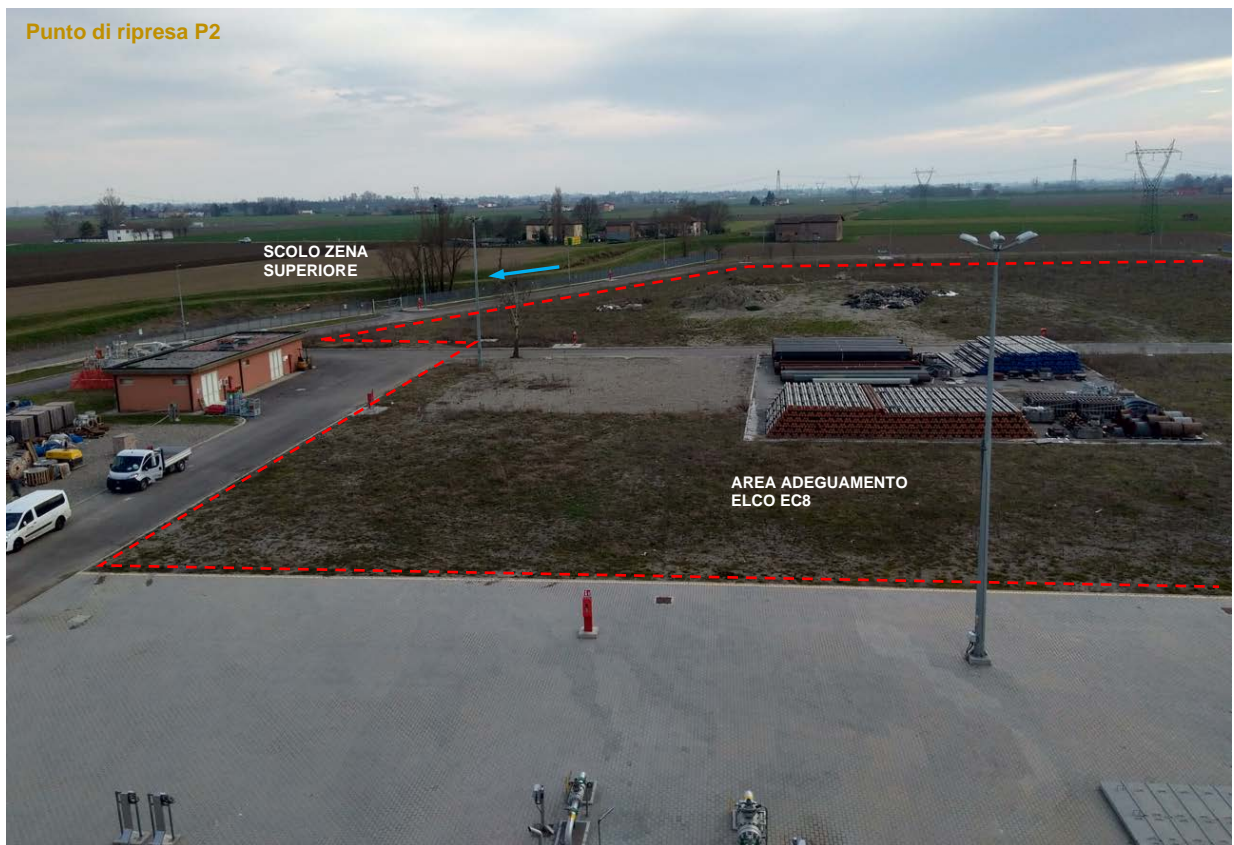
Figura 5.6 – Foto dell’ambito di intervento per la nuova unità di compressione EC8
