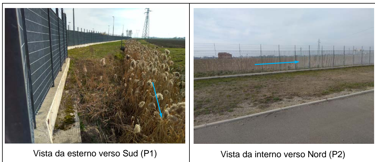
Figura 9.15 - Fosso privato sul lato Ovest della Centrale
