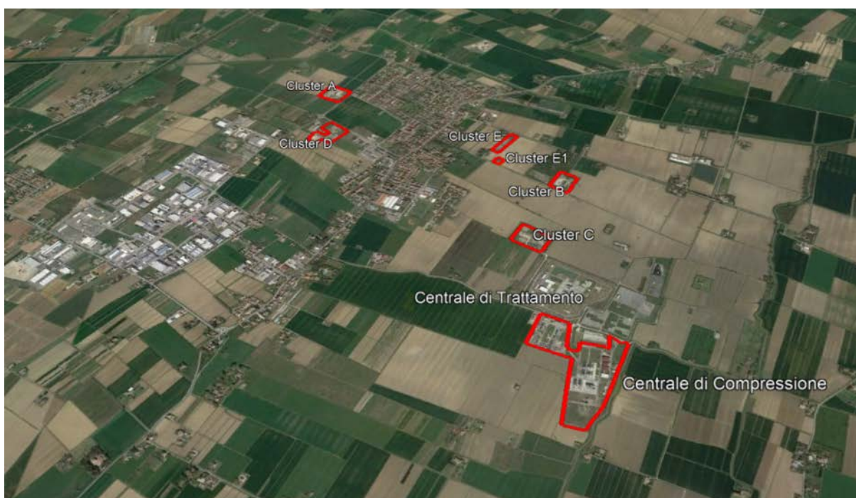
Figura 2.2-1 Concessione mineraria di Minerbio. Area di Compressione, Area di Trattamento e Cluster
