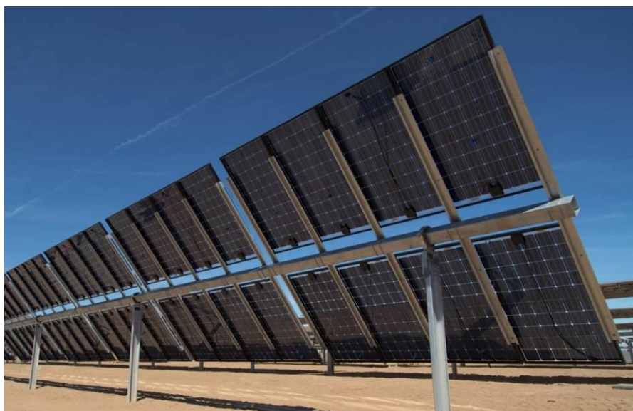
Figura 5-2 – Esempio di struttura + modulo FV bifacciale
