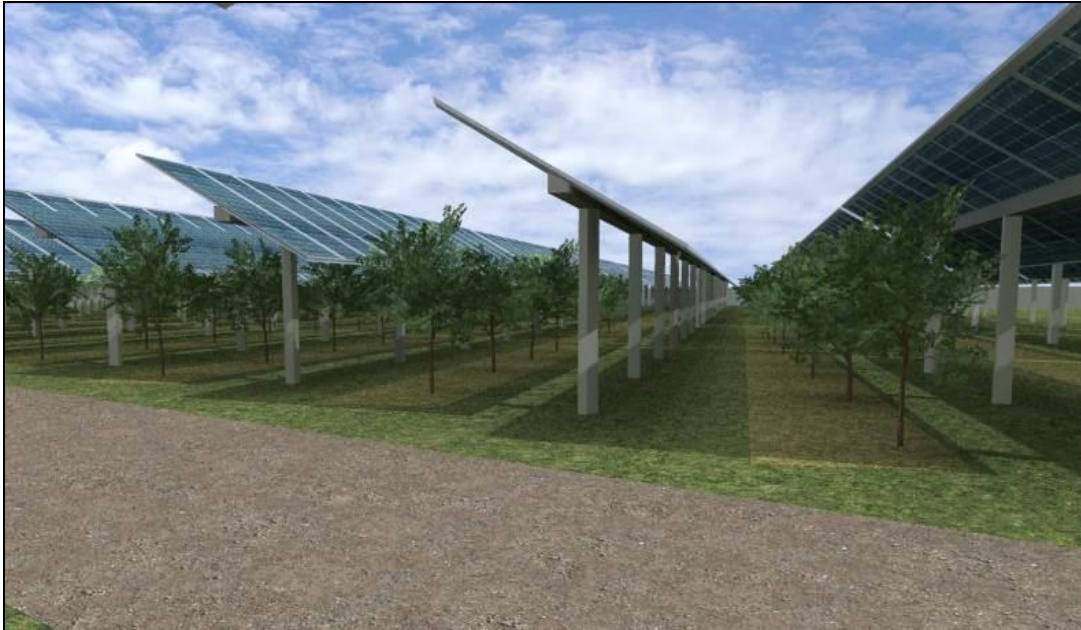
Esempio di impianto agrofotovoltaico
