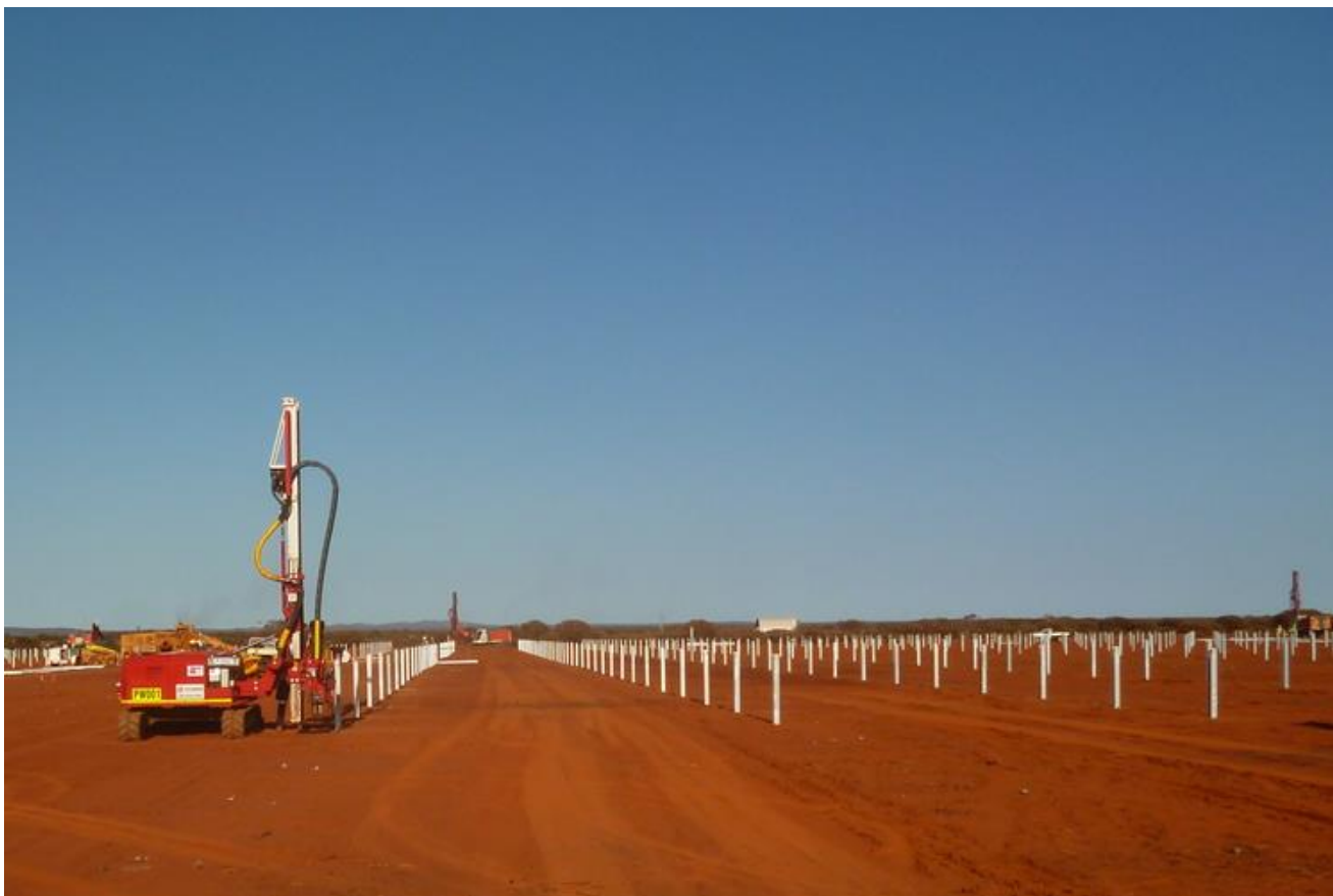
Figura 53: Infissione sostegno a mezzo di battipalo
