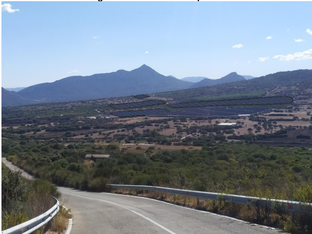
figura 9- PV2- stato post-operam
