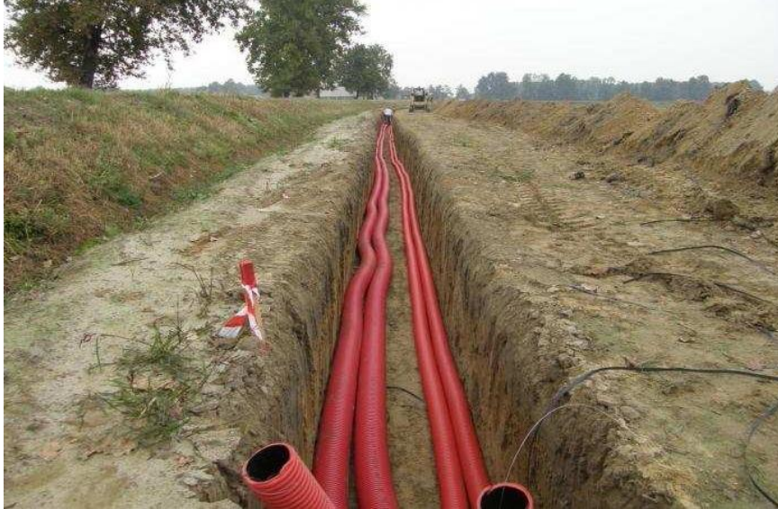
Figura 20: Scavo tipo per posa cavidotto.
