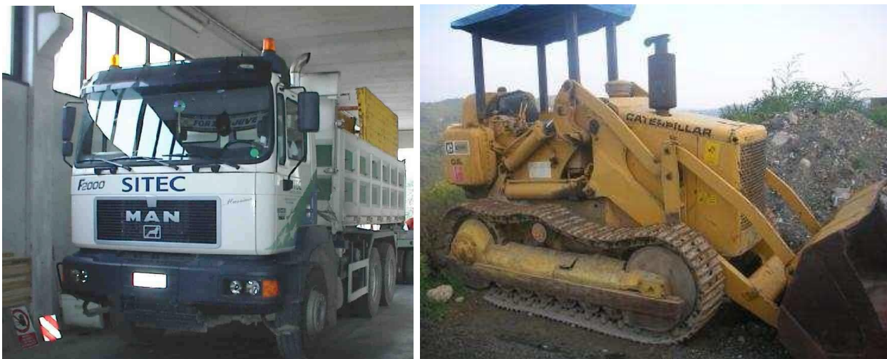
Figura 11: Esempi di macchine operatrici impegnate per la costruzione dell'impianto (Autocarro e Pala cingolata).
