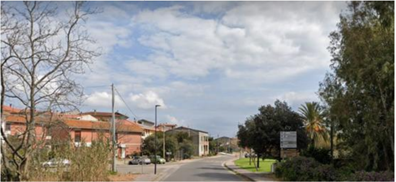
Foto 9: sopralluogo UR 6 - novembre 2021.
