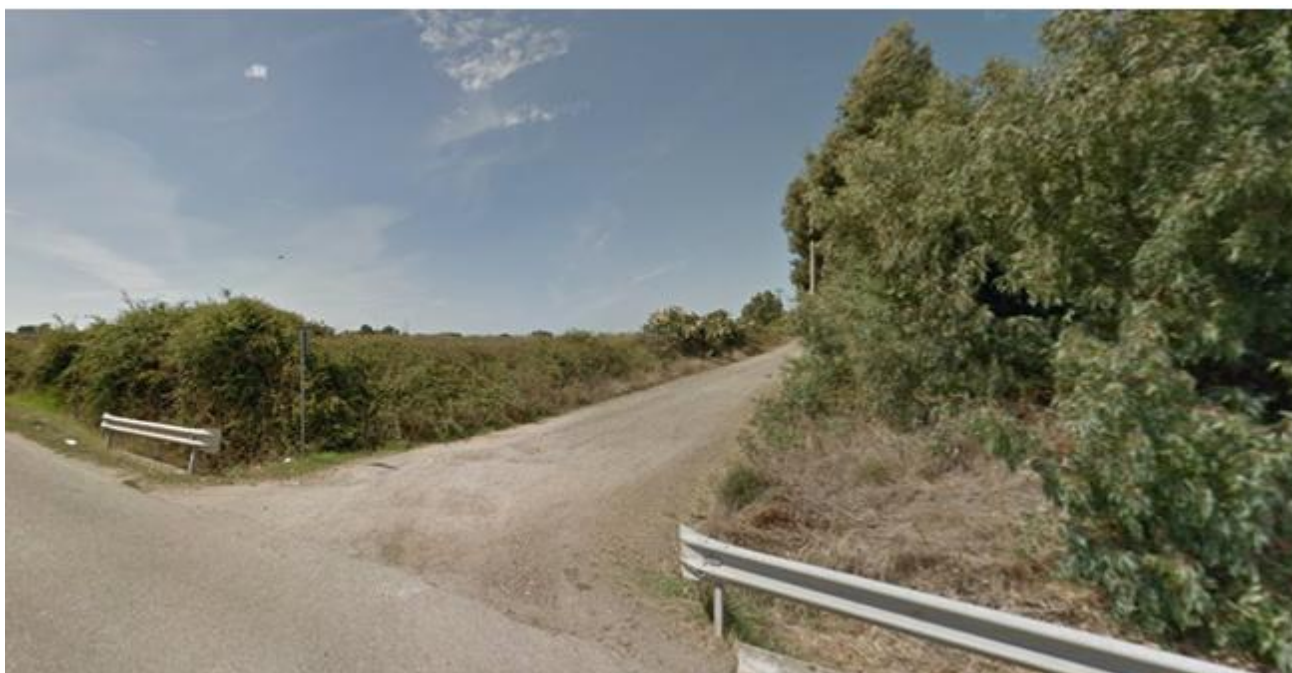
Foto 32: sopralluogo UR 23 - aprile 2022.
