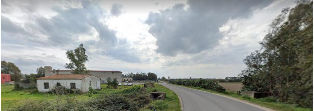
Foto 15: sopralluogo UR 11 - aprile 2022.
