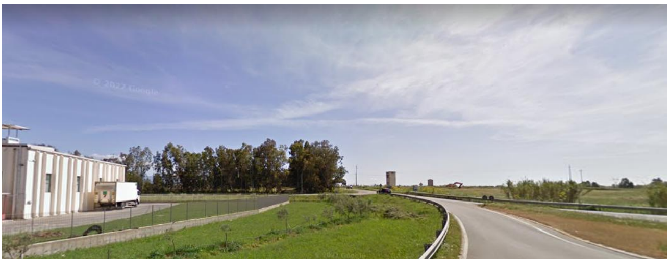
Foto 16: sopralluogo UR 12 - aprile 2022.
