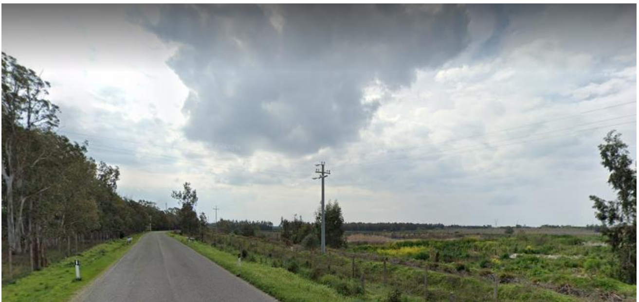
Foto 17: sopralluogo UR 13 - aprile 2022.
