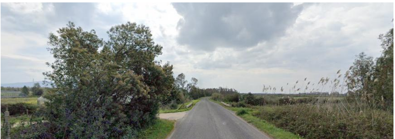
Foto 19: sopralluogo UR 15 - aprile 2022.
