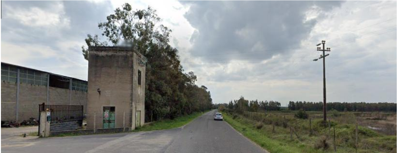
Foto 18: sopralluogo UR 14 - marzo 2022.
