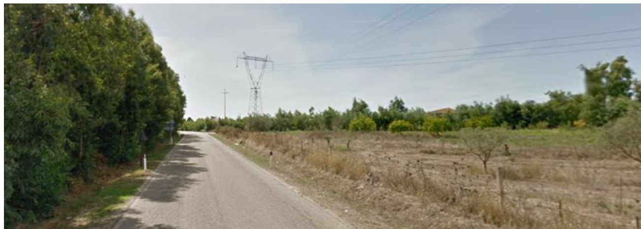
Foto 29: sopralluogo UR 20 - aprile 2022.
