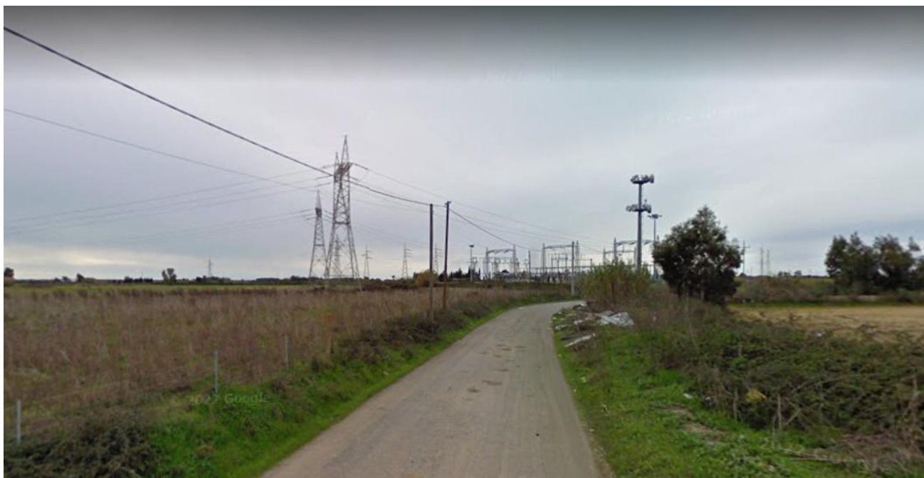
Foto 38: sopralluogo UR 25 - aprile 2022.
