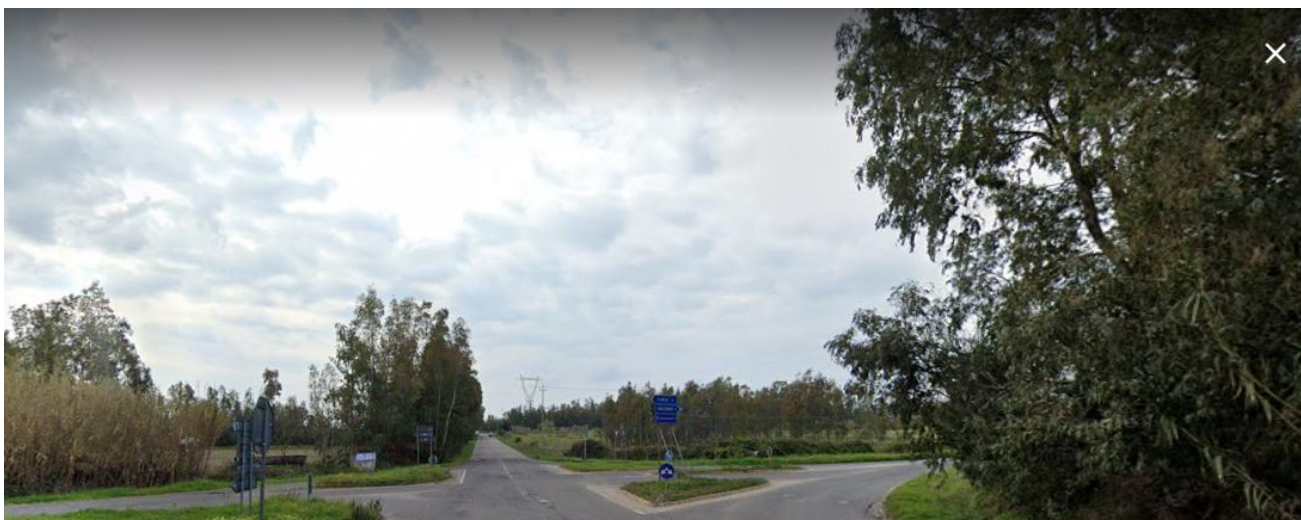
Foto 28: sopralluogo UR 20 - aprile 2022.
