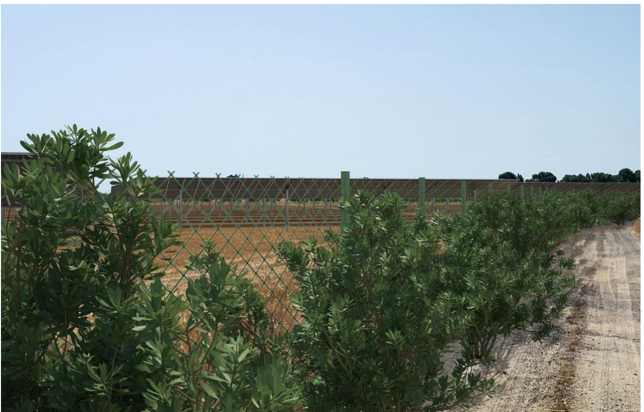
Figura 47: Vista da punto bersaglio 05 Post operam con fascia arborea di corbezzolo di mitigazione.
