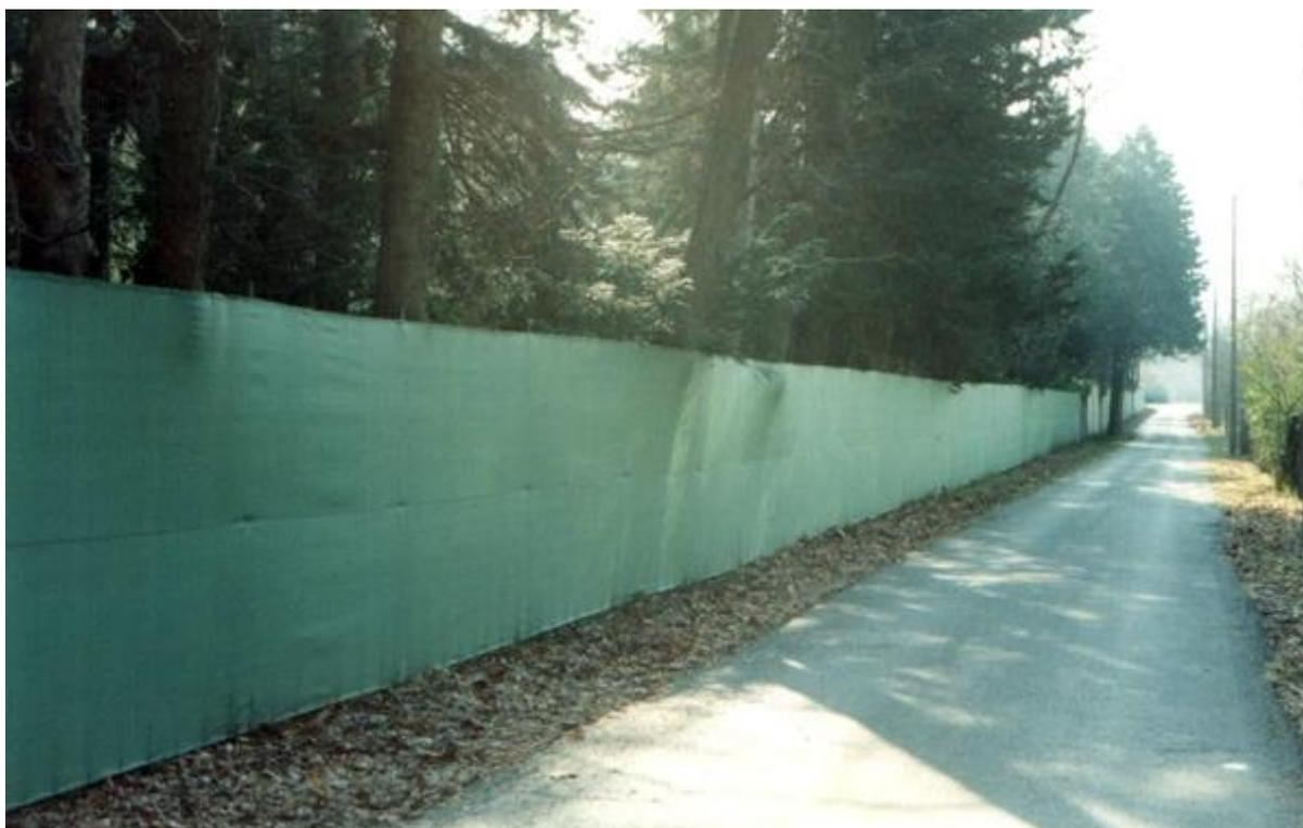
Figura 129: Esempio applicazione di reti antipolvere e frangivista.
