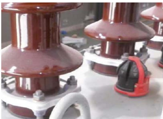
Figura 4.10: Dispositivi per movimentazione trasformatore
