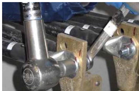
Figura 4.12: Stato di serraggio delle connessioni
