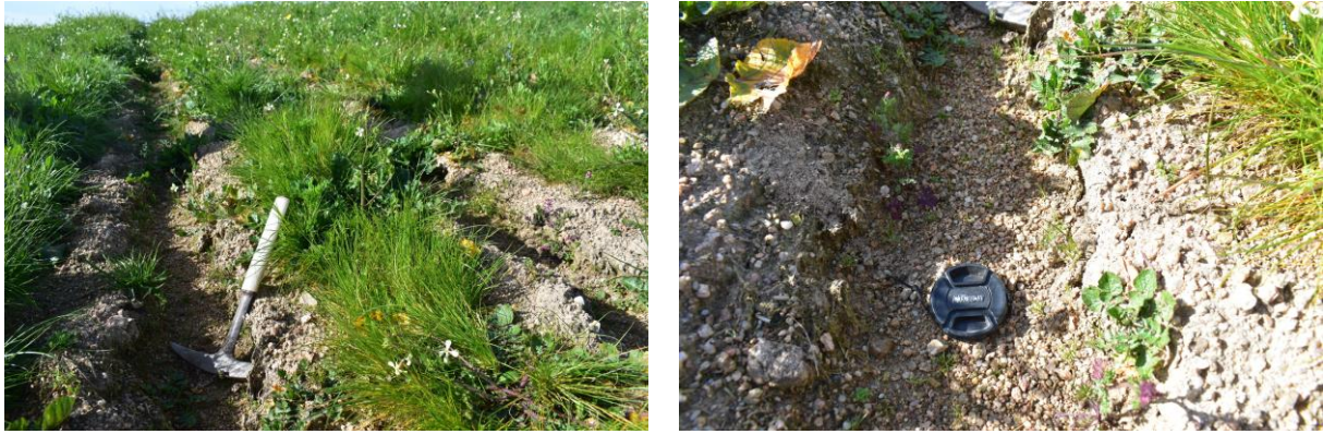
Figura 23 – Dettaglio di un solco di aratura che crea delle linee preferenziali per le acque meteoriche favorendo l’insnesco di processo erosivi.
