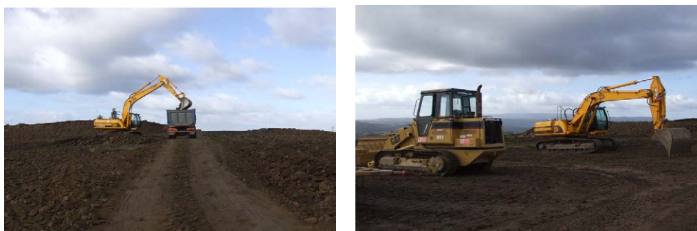
Fig. 28 – Operazioni di realizzazione piazzole
