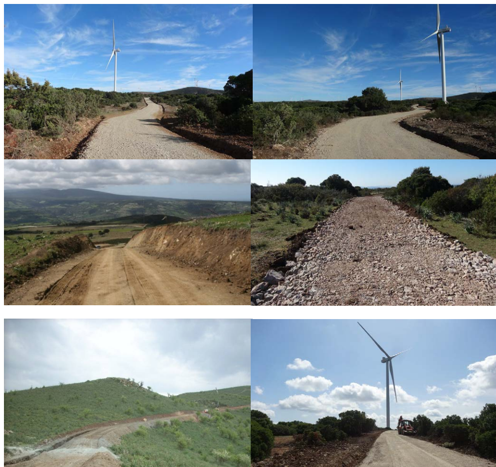
Fig. 17 – Realizzazioni tipiche di strade per parchi eolici
