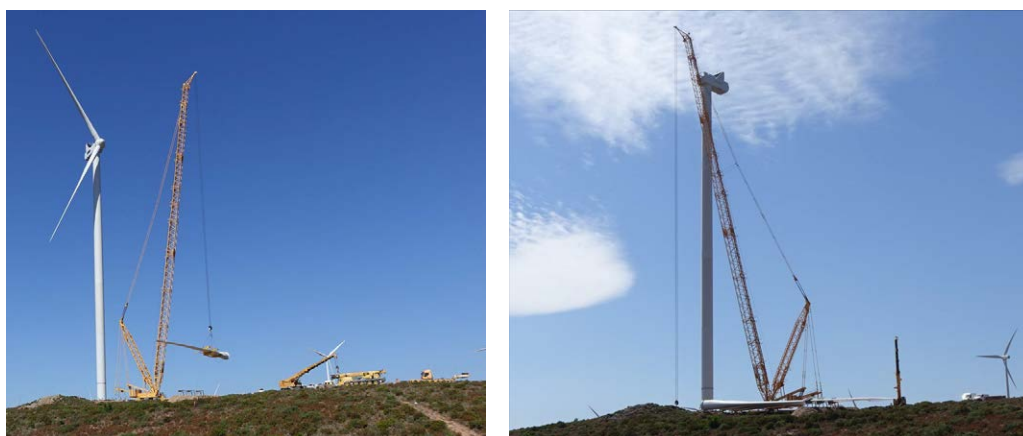
Fig. 42 – Operazioni di montaggio con gru
