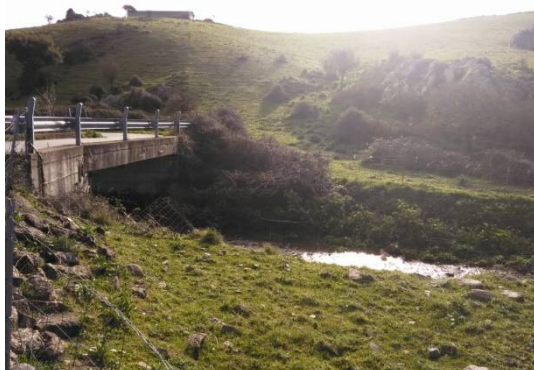
Fig. 44 – Punto di attraversamento Rio Arroglasia
