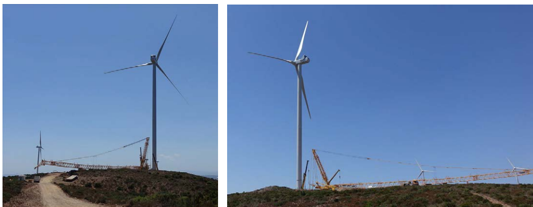
Fig. 27 – Spazi di montaggio per la gru principale
