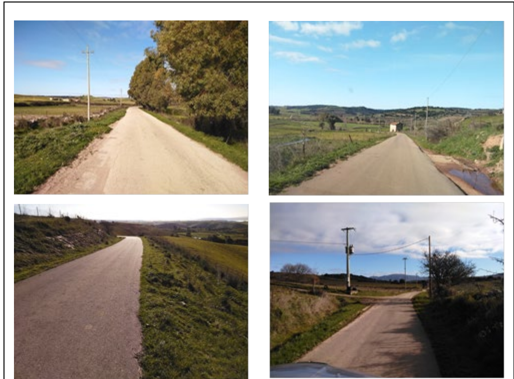
Viabilità secondaria comunale esistente - tratto asfaltato
