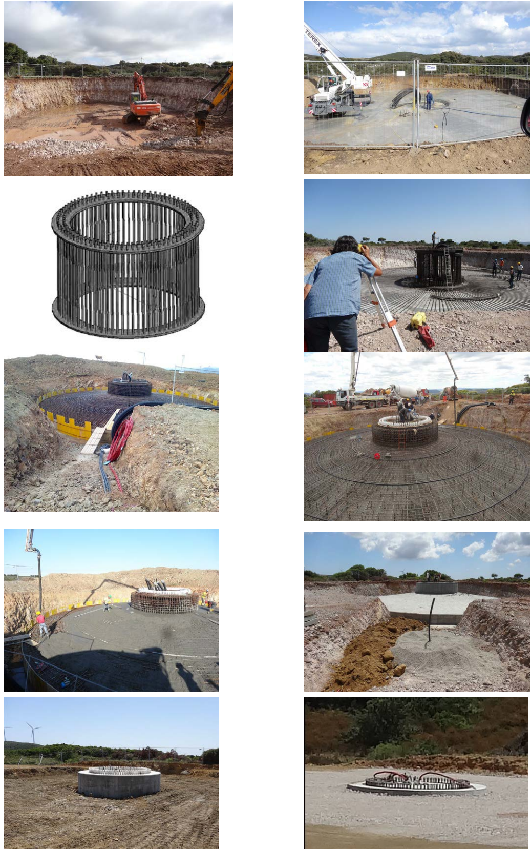
Fig. 24 – Fasi realizzative fondazioni
