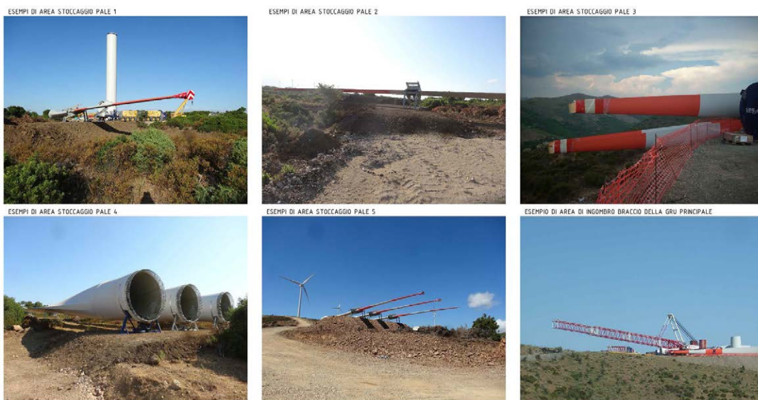
Fig. 25 – Esempi di stoccaggio pale
