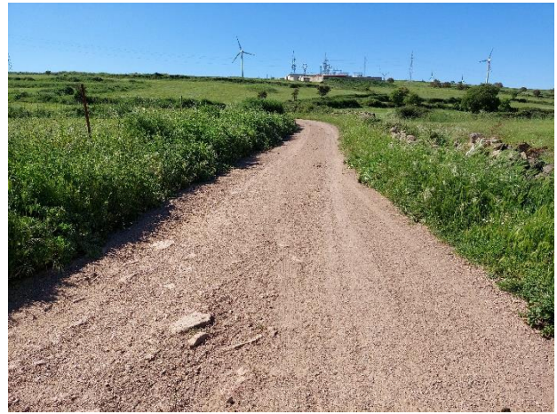
Figura 30 - Tracciato di posa del cavidotto su sterrato in avvicinamento alla sottostazione elettrica
