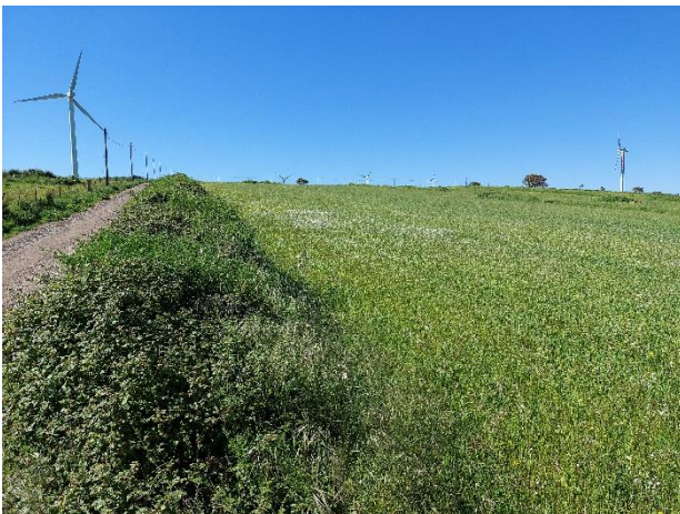
Figura 31 - Sito di realizzazione della sottostazione elettrica, vista SE → NW
