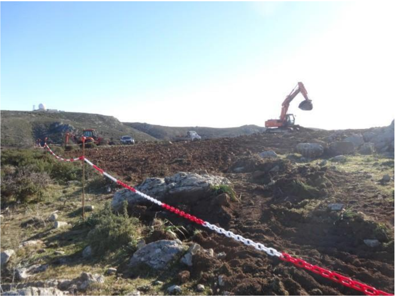
Figura 29 - Esempio di delimitazione dell'area di cantiere finalizzata all'esclusione delle superfici limitrofe. Fonte: Sardeolica, Relazione tecnica relativa alla fase di cantiere per l'ampliamento del parco eolico “Maistu” – Ulassai
