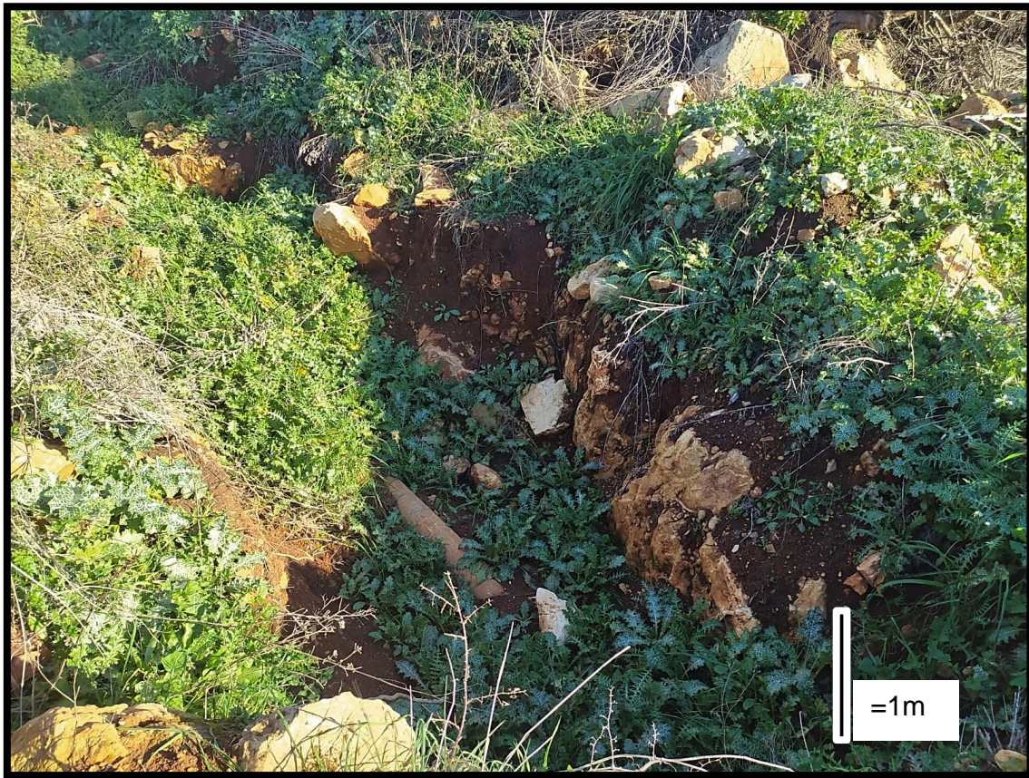
Figura 10: Scavo della trincea per la posa della condotta.
