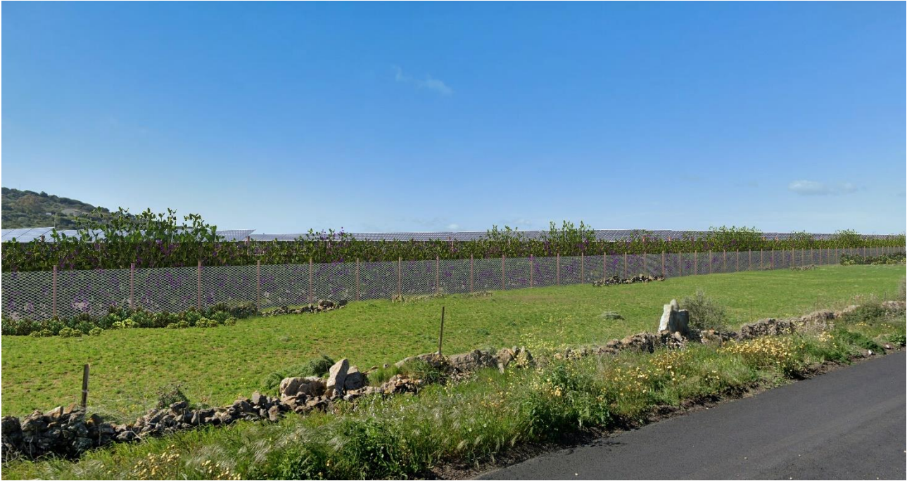
Figura 10: Cono di ripresa n.2 vista da SP65 – Verso Sud post operam
