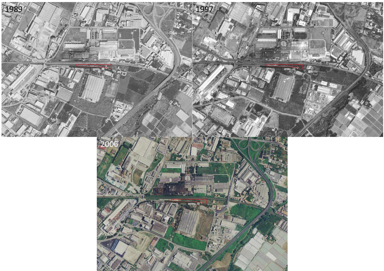
Figura 4-1 Vista aerea dell'area di progetto (fonte: Geoportale Nazionale)
