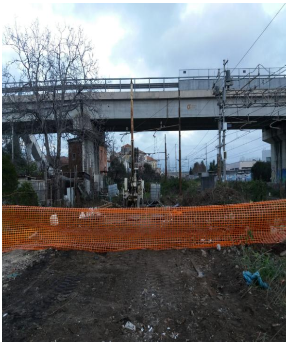
Postazione SONDAGGIO BH 10
