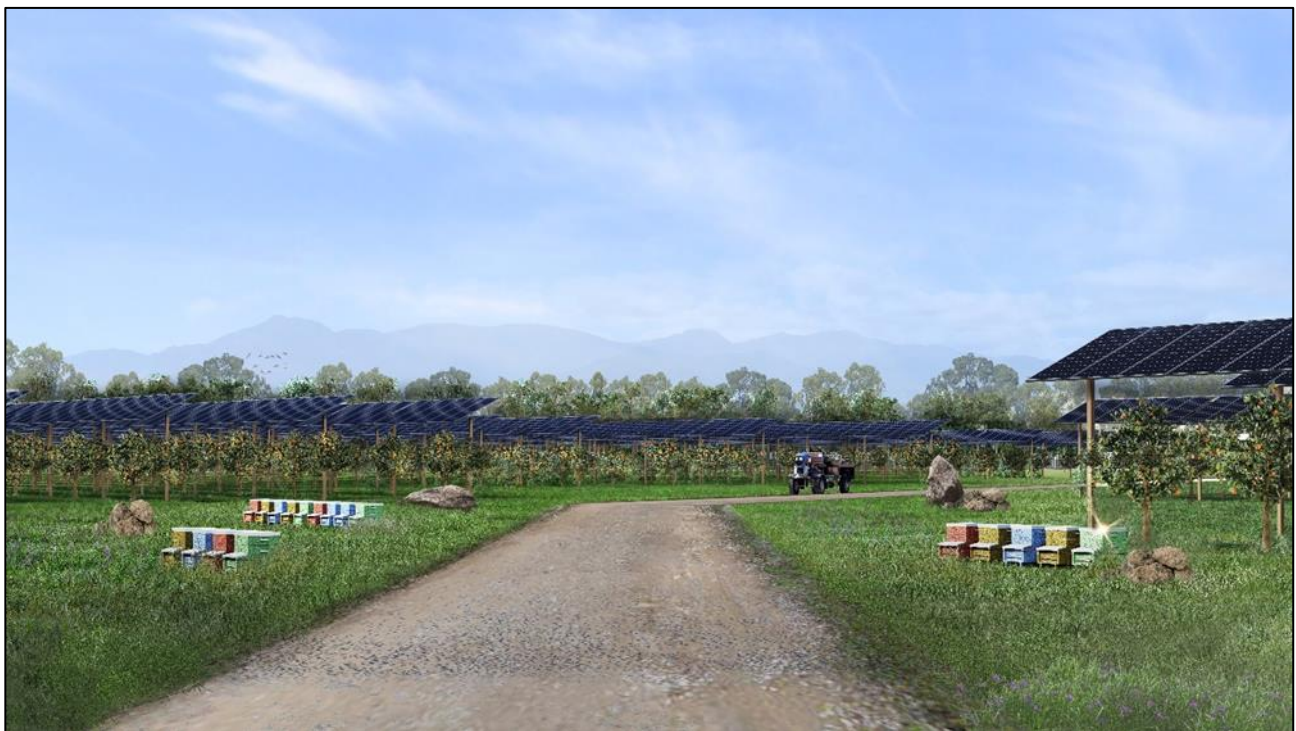
Figura 2: Esempio di impianto agrivoltaico con integrazione dell'attività di apicoltura – Vista dall'interno
