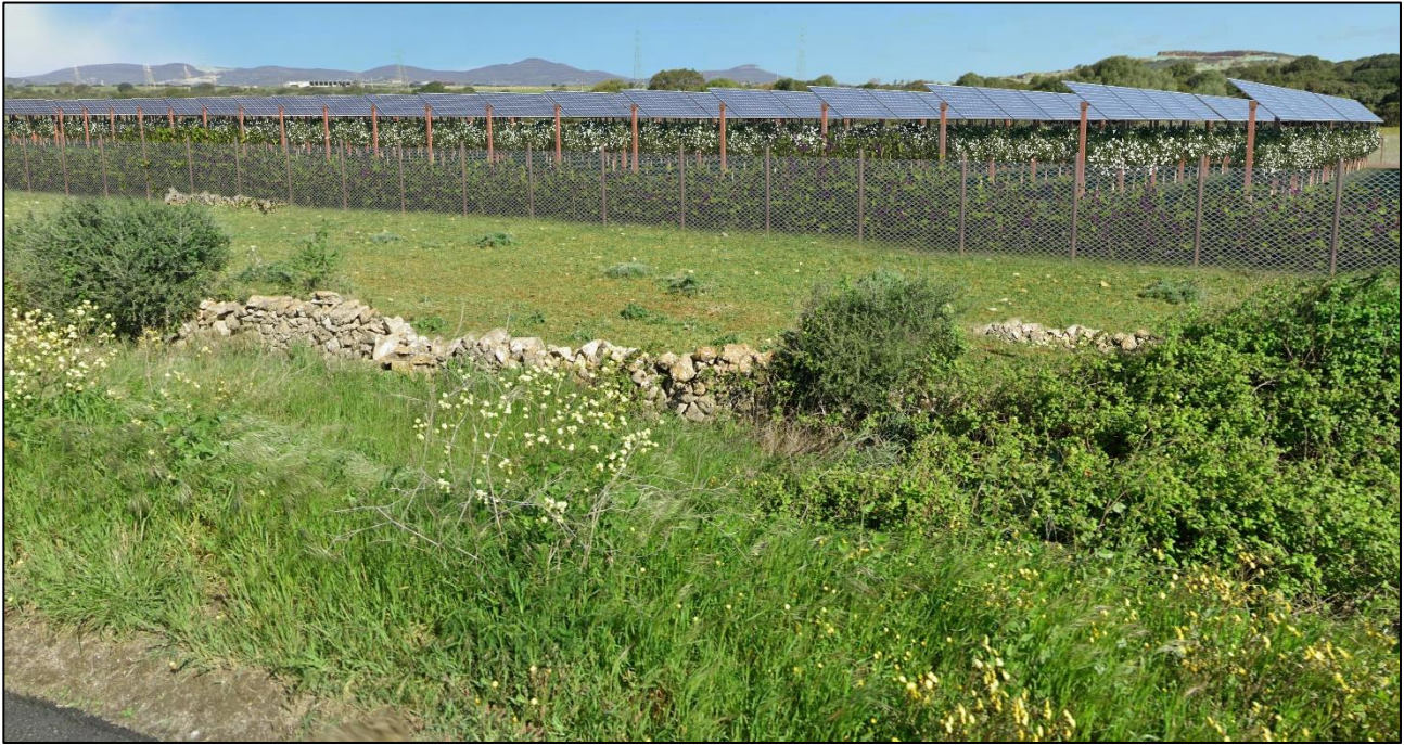
Figura 29: Cono di ripresa n.3 vista da SP65 – Verso Nord intra operam
