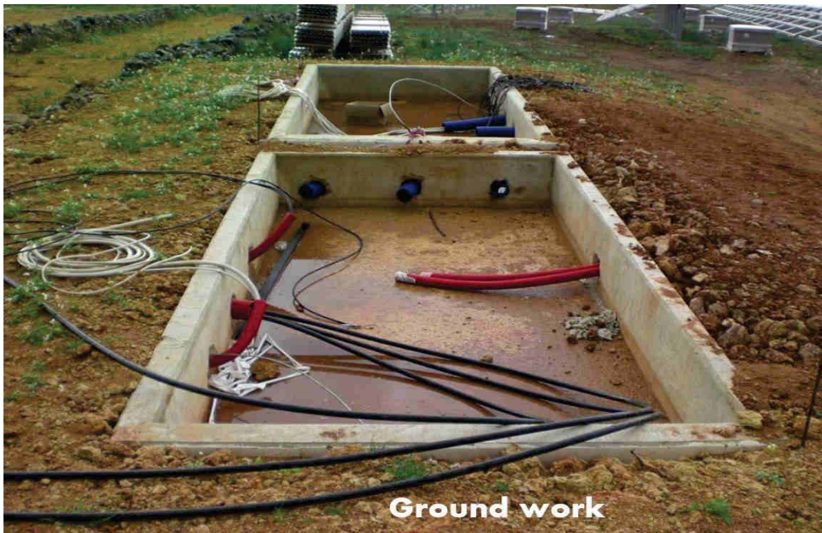
Figura 17 - Esempio basamento cabina
