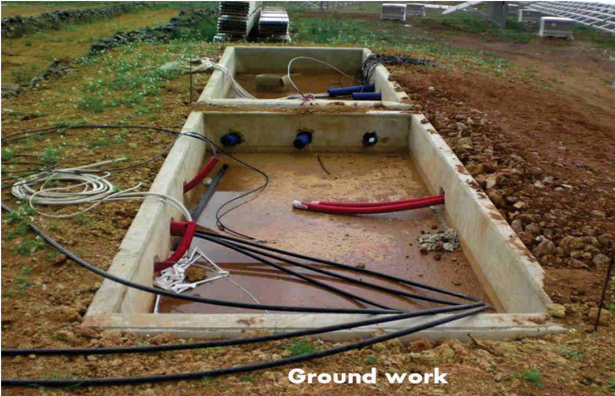
Figura 10 - Esempio basamento cabina
