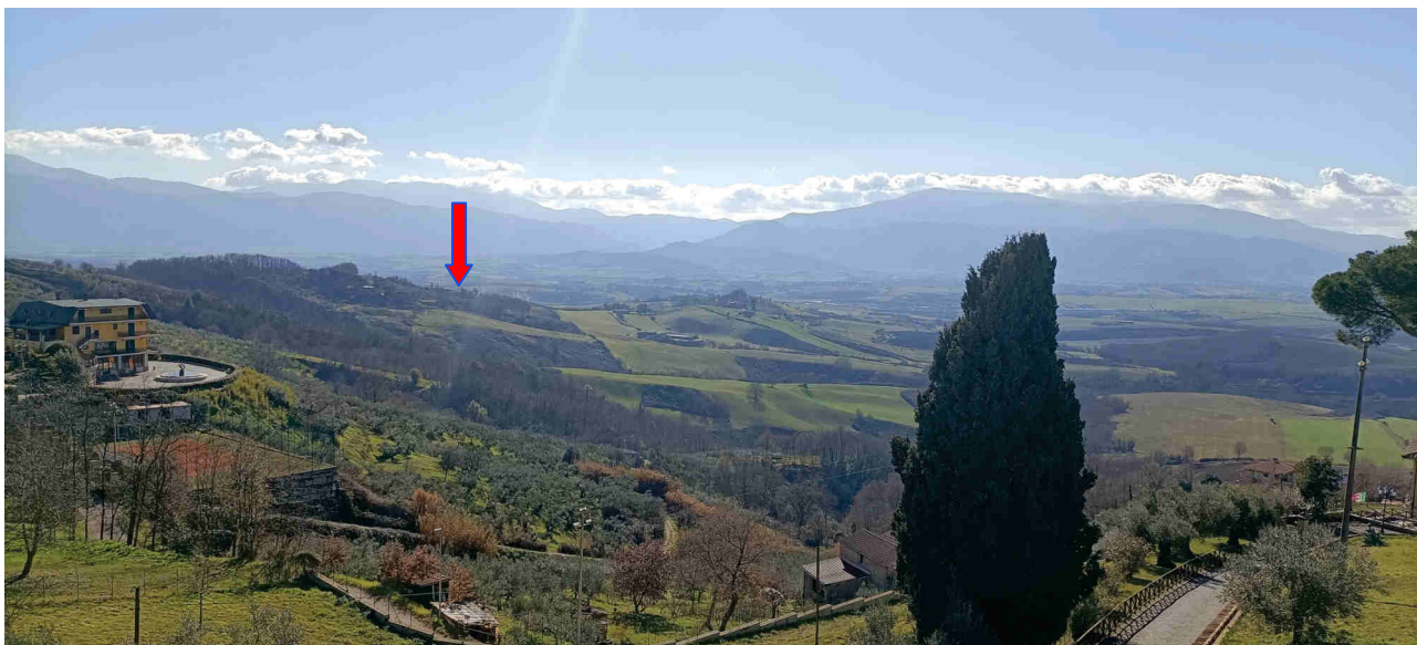
Figura 23 - Visuale 2 da Paliano convento Padri Passionisti. L'impianto risulta naturalmente schermato dalla collina antistante.
