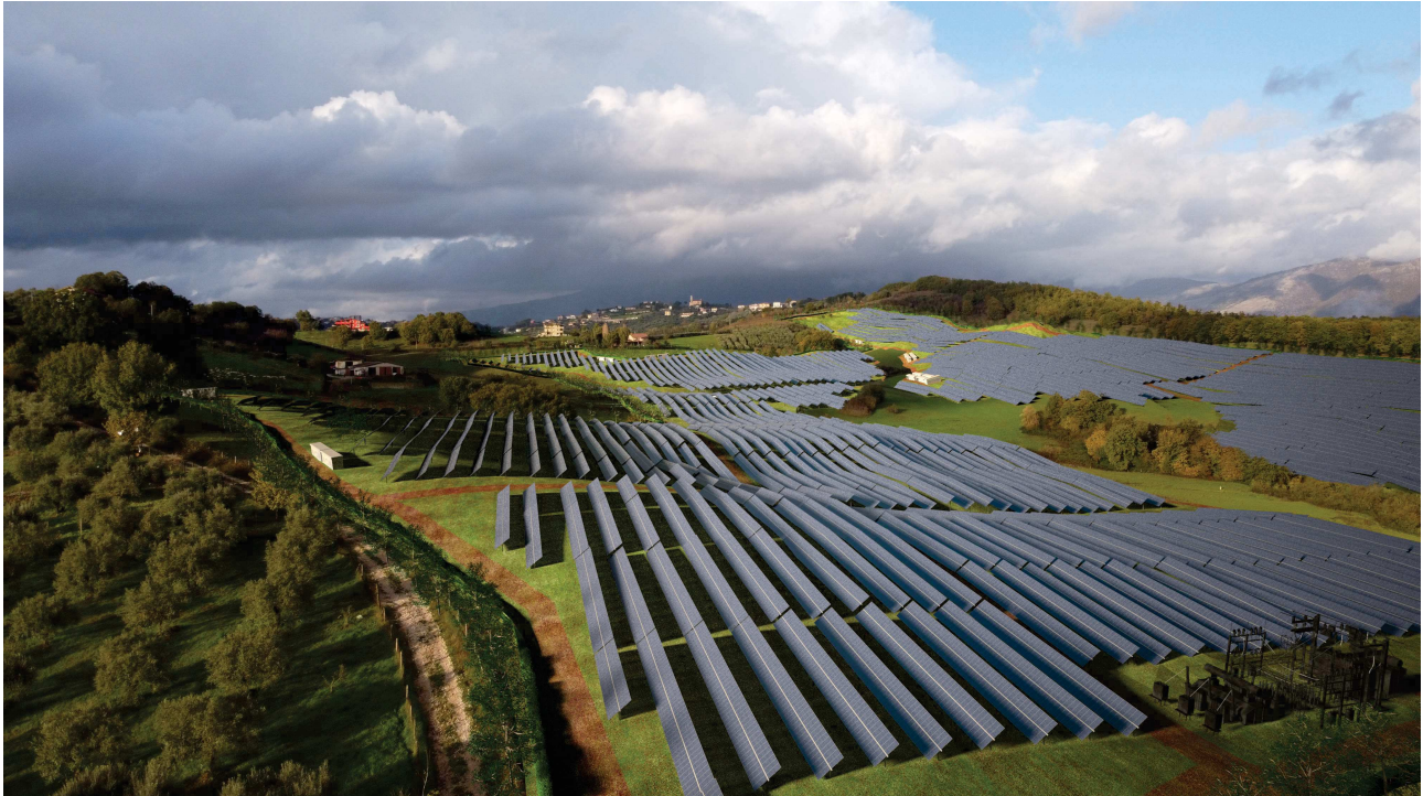
Figura 15 – vista 1 Ante Operam
