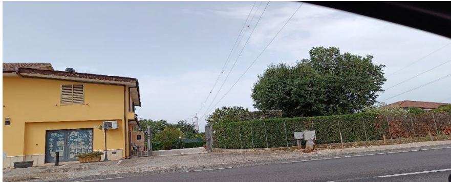
Figura 12: Manufatto n°19 a sx con Sostegno n° 35
