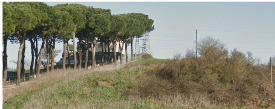
Manufatti n°5-6-7-8-9 e Sostegno n° 13
