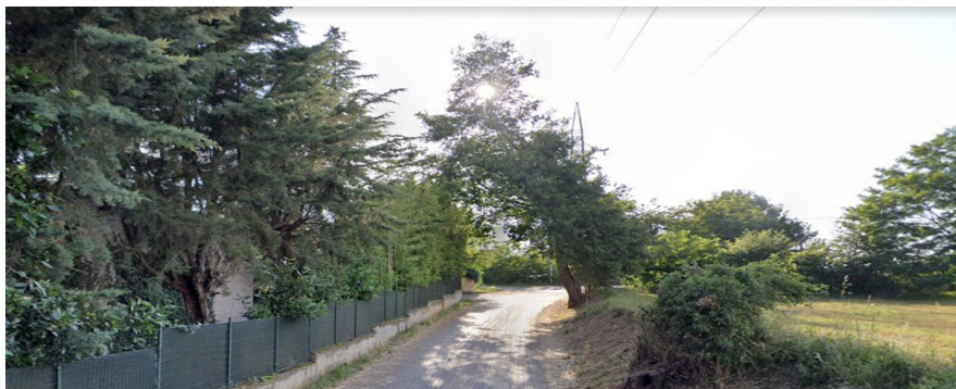
Manufatto n° 13 a dx e Sostegno n° 30
