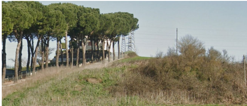
Manufatti n°5-6-7-8-9 e Sostegno n° 13
