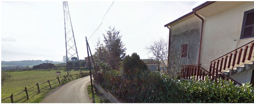
Manufatto n°12 a dx e Sostegno n° 30
