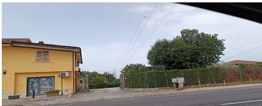
Figura 12: Manufatto n° 20 a dx con Sostegno n° 35
