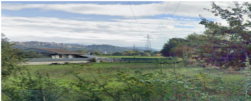
Manufatto n° 14 a sx e Sostegno n°34
