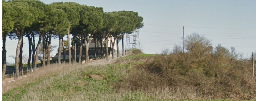
Manufatti n°5-6-7-8-9 e Sostegno n° 13
