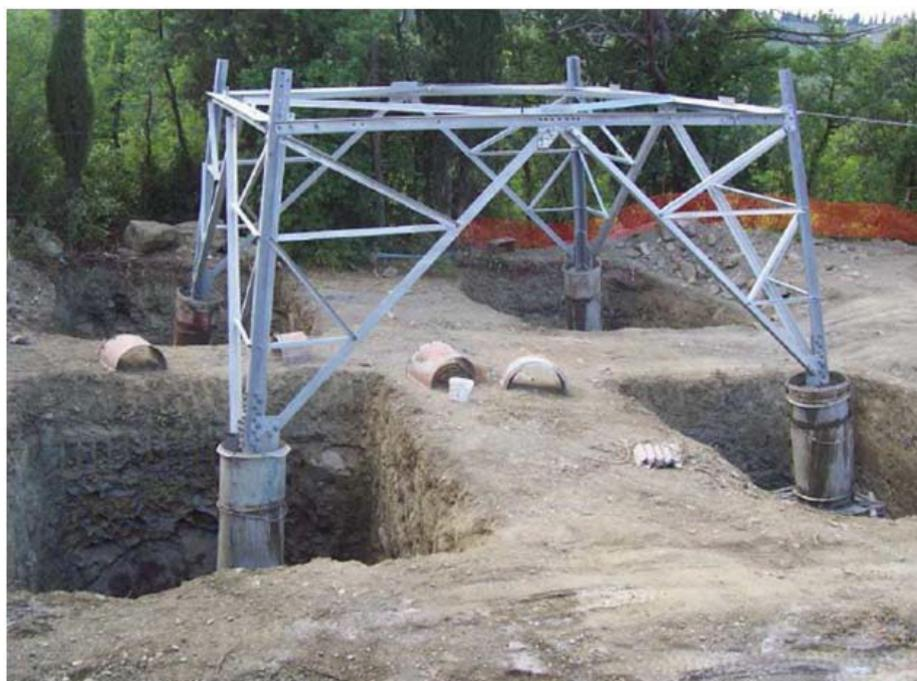
Il plinto è composto da una parte inferiore (piede) conformato a gradoni, su cui è impostato un pilastro a sezione circolare avente altezza variabile.
