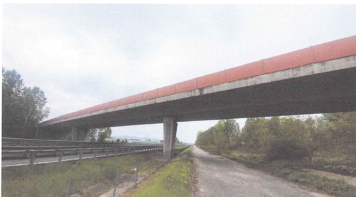
Vista del ponte incompleto
