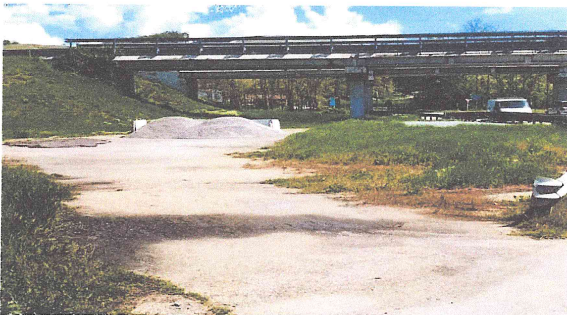
Reliquato stradale asfaltato "Oa"
