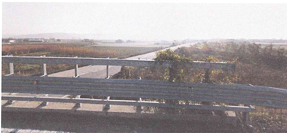
Vista del reliquato stradale
