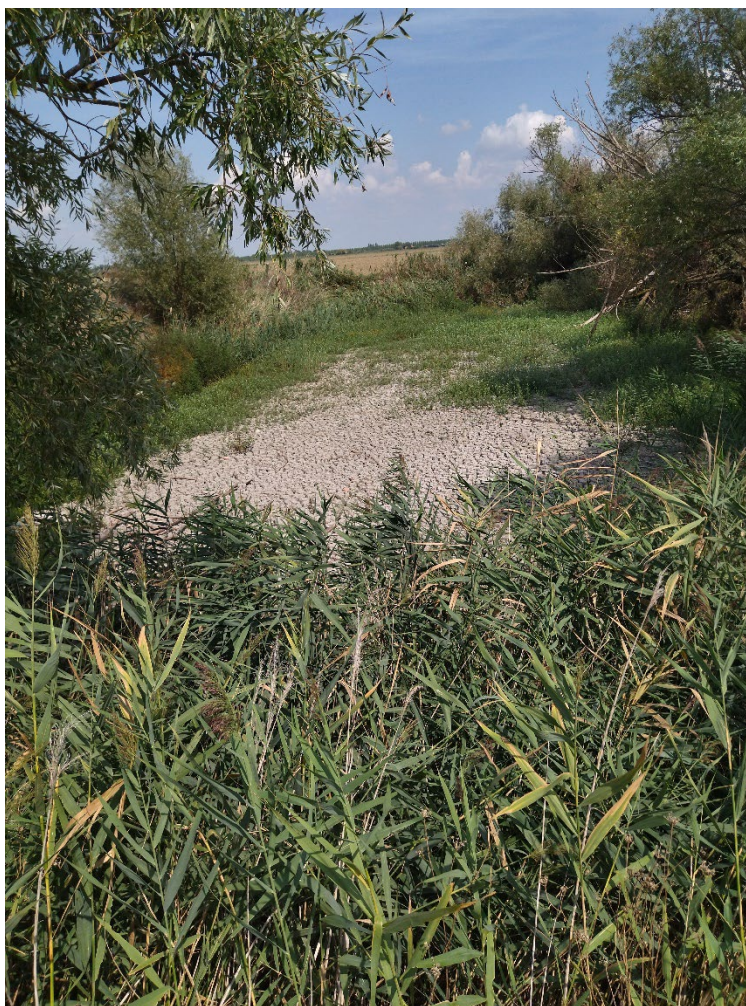
Figura 22 – Bacino di accumulo asciutto localizzato nei pressi del Lotto 1, con presenza di vegetazione igrofila
