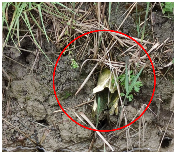
Figura 8: Sbocco delle tubazioni interrato (DN=7 cm) sui canali principali di drenaggio in terra.
