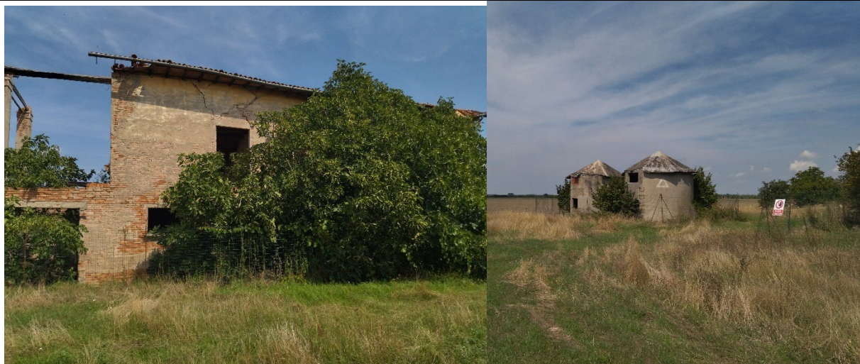
Figura 20 - Lotto 4: Edifici rurali dismessi
