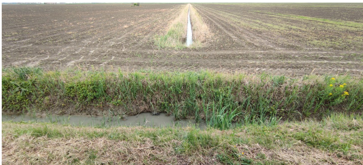
Figura 7: Dettaglio su canali di drenaggio interni e perimetrali all'area di impianto.
