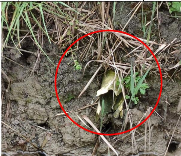
**Figura 10 - Sbocco delle tubazioni interrate (DN=7 cm) sui canali principali di drenaggio in terra.**
