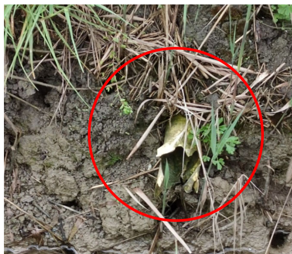
Figura 6: Sbocco delle tubazioni interrate (DN=7 cm) sui canali principali di drenaggio in terra.
