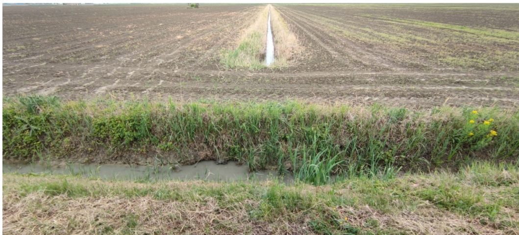
Figura 5: Dettaglio su canali di drenaggio interni e perimetrali all'area di impianto.
