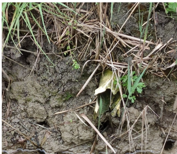
Figura 5 - Sbocco delle tubazioni interrato (DN70) sui canali di drenaggio in terra
