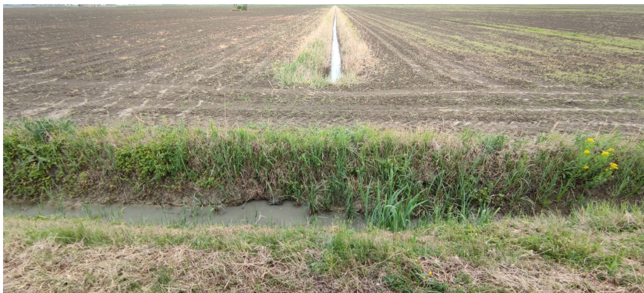
Figura 16: Dettaglio su canali di drenaggio interni e perimetrali all’area di impianto.
