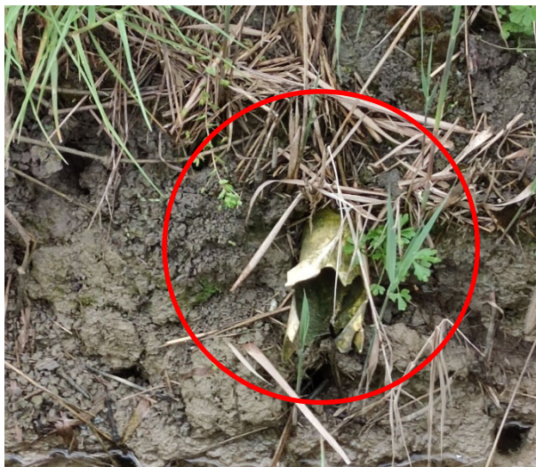
Figura 17: Sbocco delle tubazioni interrate (DN=7 cm) sui canali principali di drenaggio in terra.
