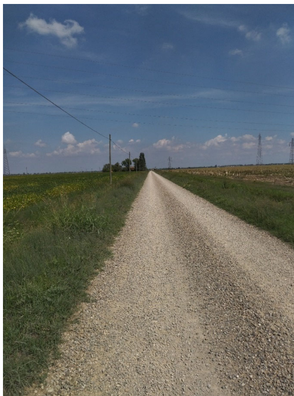
Figura 14 – Viabilità esistente su cui ricade il cavidotto di connessione alla Cabina Primaria di Medicina
