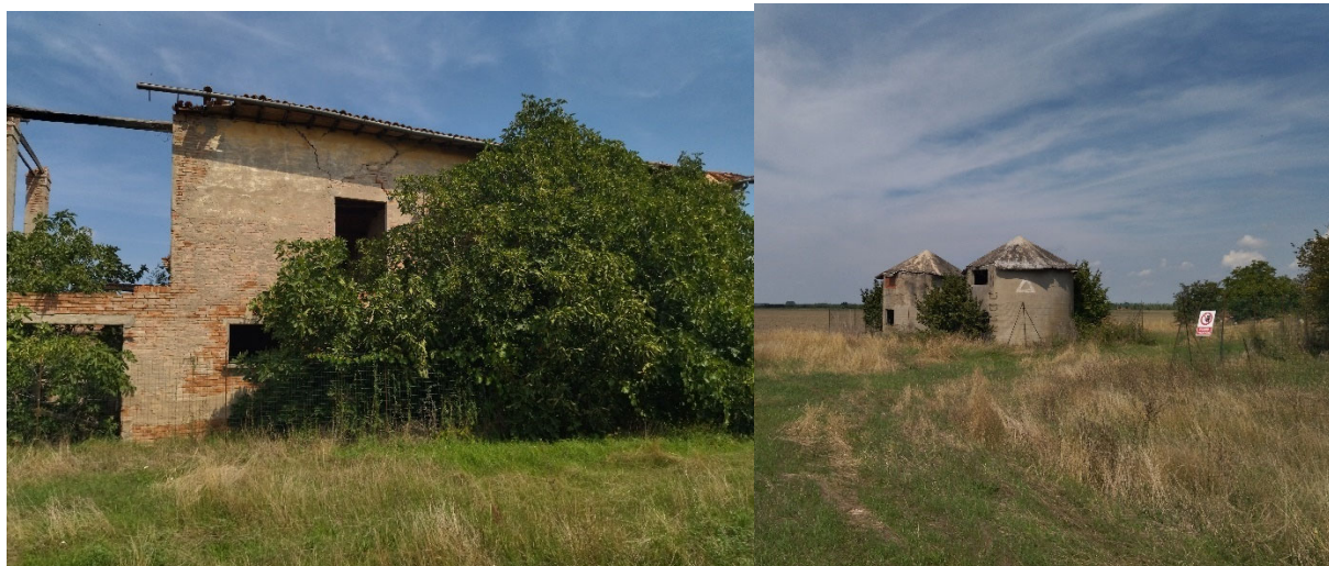
Figura 11 - Lotto 4: Edifici rurali dismessi
