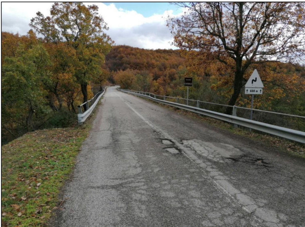
PARTICOLARE DEL PONTE SUL TORRENTE CASALE
