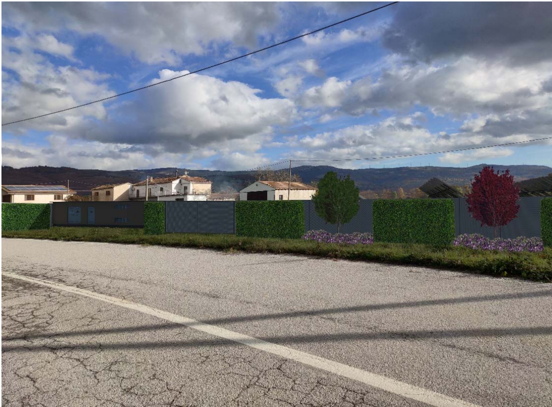
Foto 6 – Vista dalla SS 103
