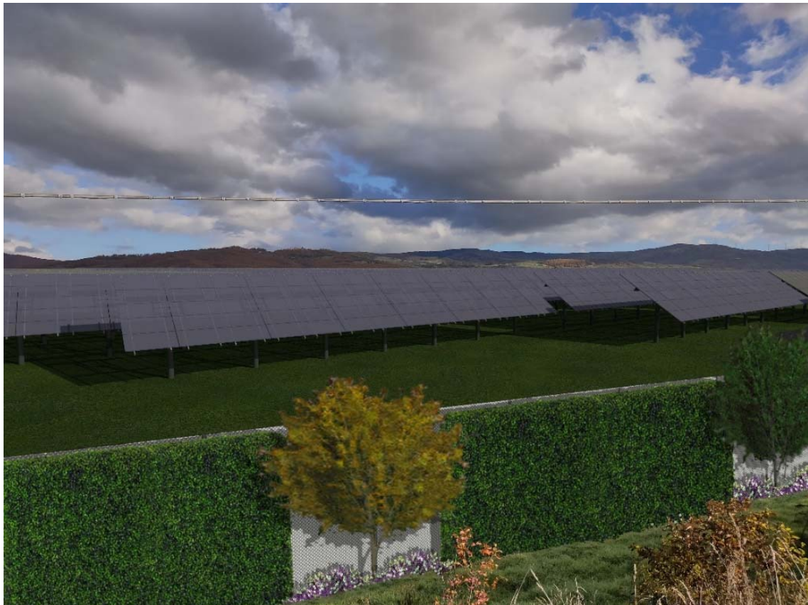
Foto 1 – Vista lato sud
