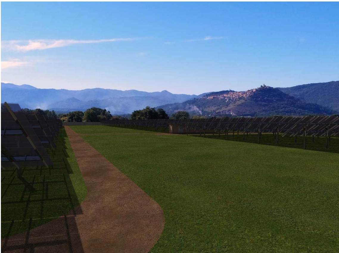
Foto 5 – Vista interna impianto Grumento 2
