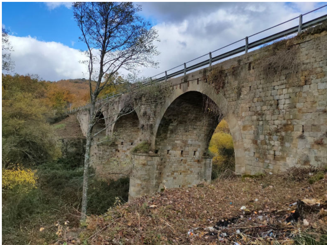
Foto 8 - Vista attraversamento torrente Casale
