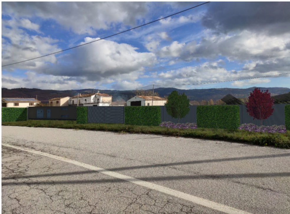
Foto 6 – Vista dalla SS 103
