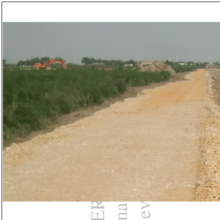
Figura 6 – strada di accesso tipo realizzata con misto stabilizzato.
