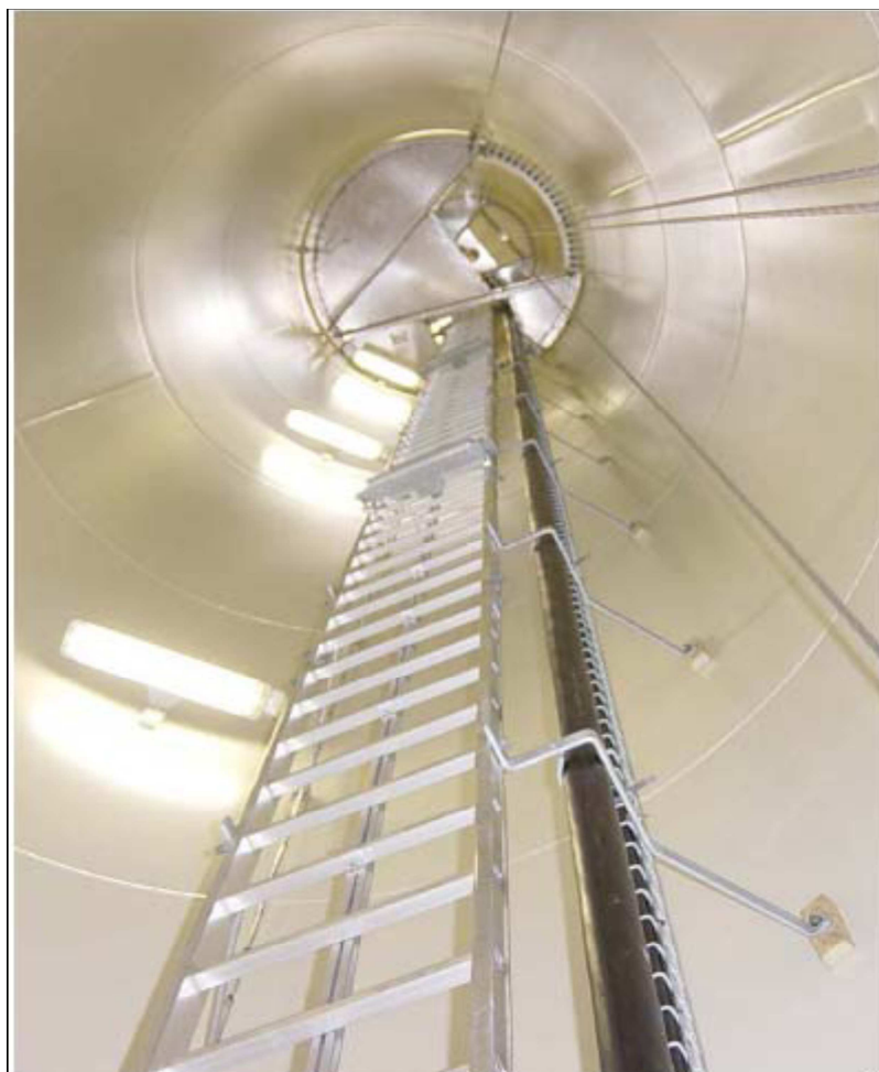
Figura 4 – Interno torre tubolare.
