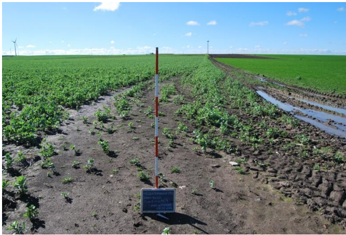
Foto 50: cavidotto di accesso all'aerogeneratore 9 visto da NE (f.7 partt.230,36,574, 566, 565)
