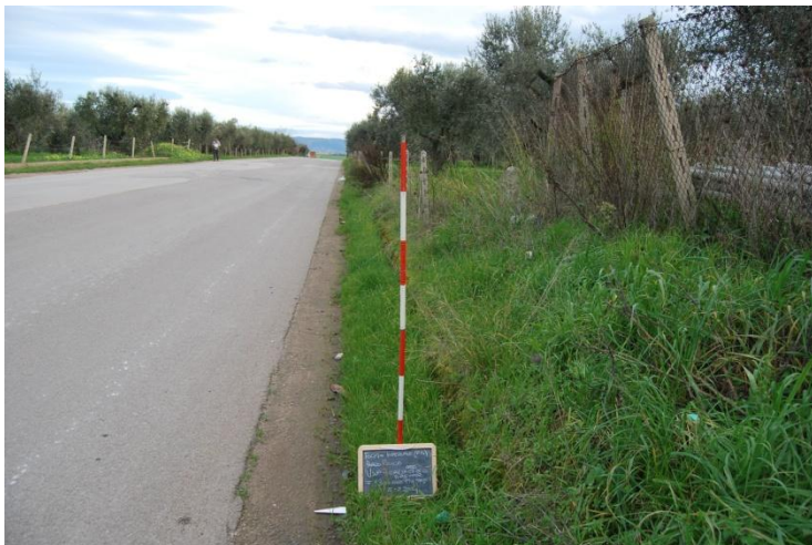
Foto 42: cavidotto di collegamento tra gli PG 27, 26, 24 e Poggio Imperiale visto da O, III parte (f.14 lato sud partt. 2099, 2226,2360, 1968, 1843, 2637, 2646, 2214, 2388, 238, 235, 330, 617, 831, 747, 791, 237, 236, 601, 666; f. 13 lato nord1911, 2360, 76, 1912, 2430, 1919, 327, 326, 228, 175, 307, 309, 221, 662, 516, 517, 107, 182, 150, 237, 236, 101, 99)
