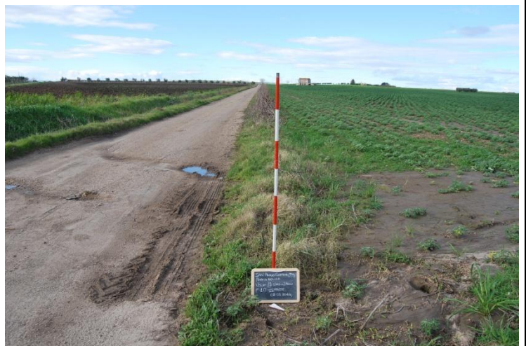
Foto 74: cavidotto di collegamento lungo strada vicinale visto da NE, III parte (f.10 lato nord 346, 340, 234, 235, 239; lato sud 41, 195, 337, 335)
