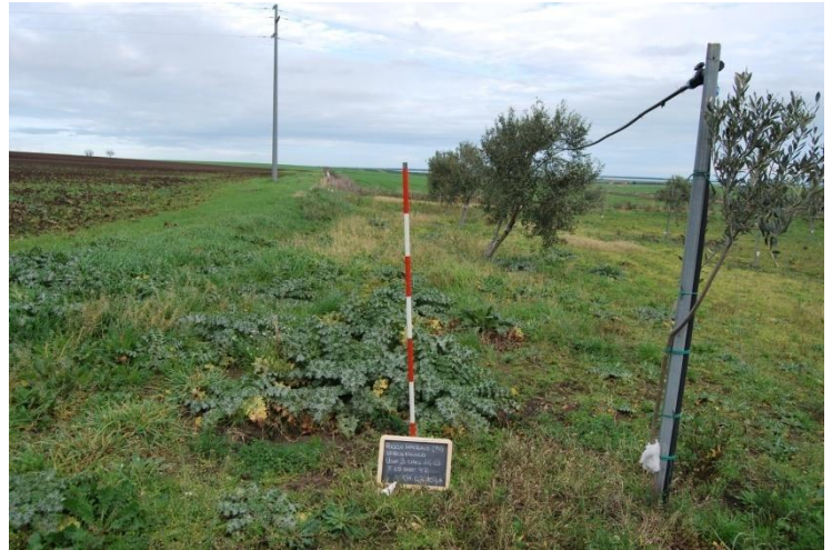
Foto 14: cavidotto di accesso all'aerogeneratore 13 visto da S(f.19 partt.110, 197)
