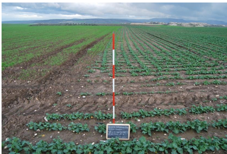
Foto 25: cavidotto di accesso all'aerogeneratore 26 visto da O (f.22, partt. 203, 208, 19)
