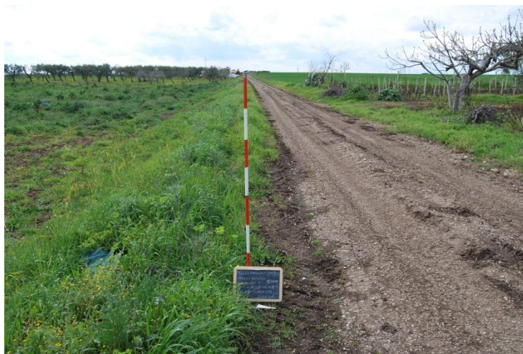
Foto 67: cavidotto di collegamento tra gli aerogeneratori 14 B e 16 B II parte, visto da est
