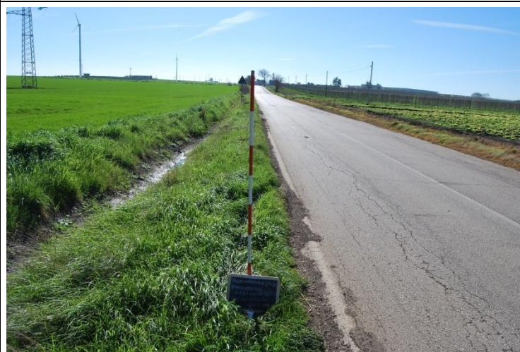
Foto 71: cavidotto di collegamento posto lungo S.P. 35 visto da N
