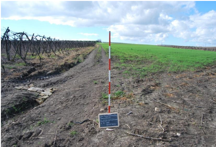
Foto 76: cavidotto di accesso alla sottostazione visto da E (f.10 lato nord-ovest 67, 117, 111, lato sud-est 119, 360, 365)
