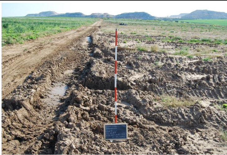
Foto 22: cavidotto di accesso all'aerogeneratore 27 visto da N (f.22, partt. 18,73,194,195,196,25,78,199,200,201)
