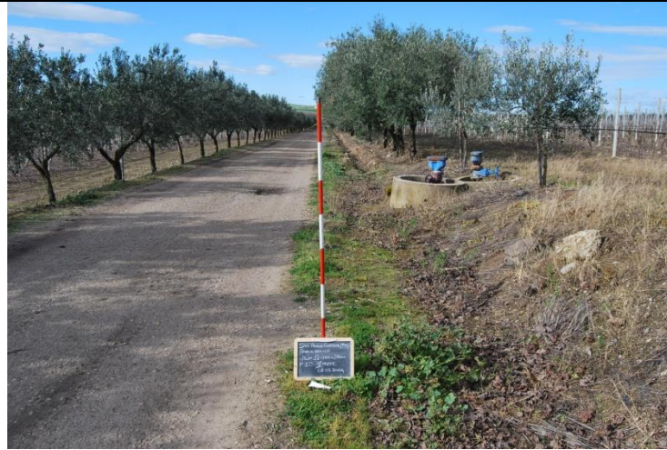
Foto 75: cavidotto di collegamento lungo strada vicinale visto da E, IV parte (f.10 lato nord 240, 36, 7, 217, 378, 381, 125; lato sud 29, 284, 292, 119)
