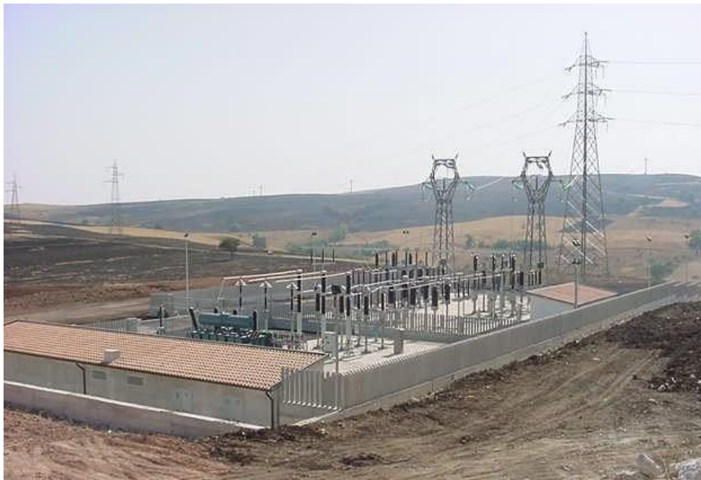
Esempio di Stazione di Utanza MT/AT
