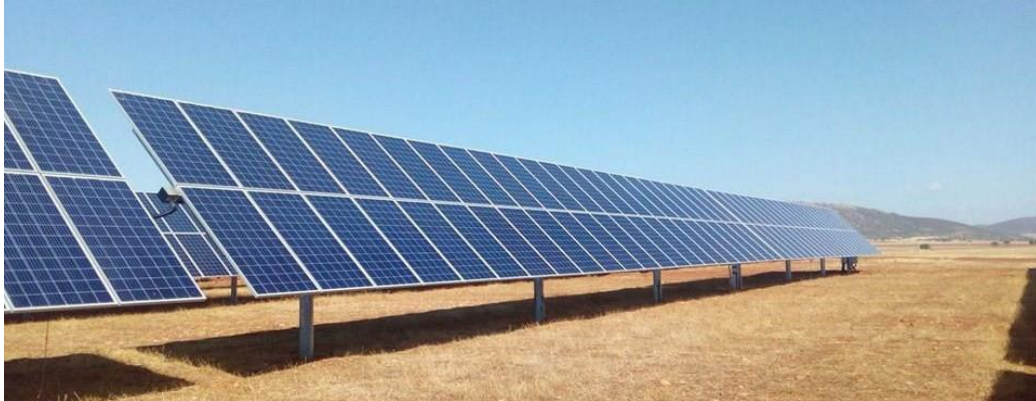
Figura 7 - Particolare del tracker in oggetto
