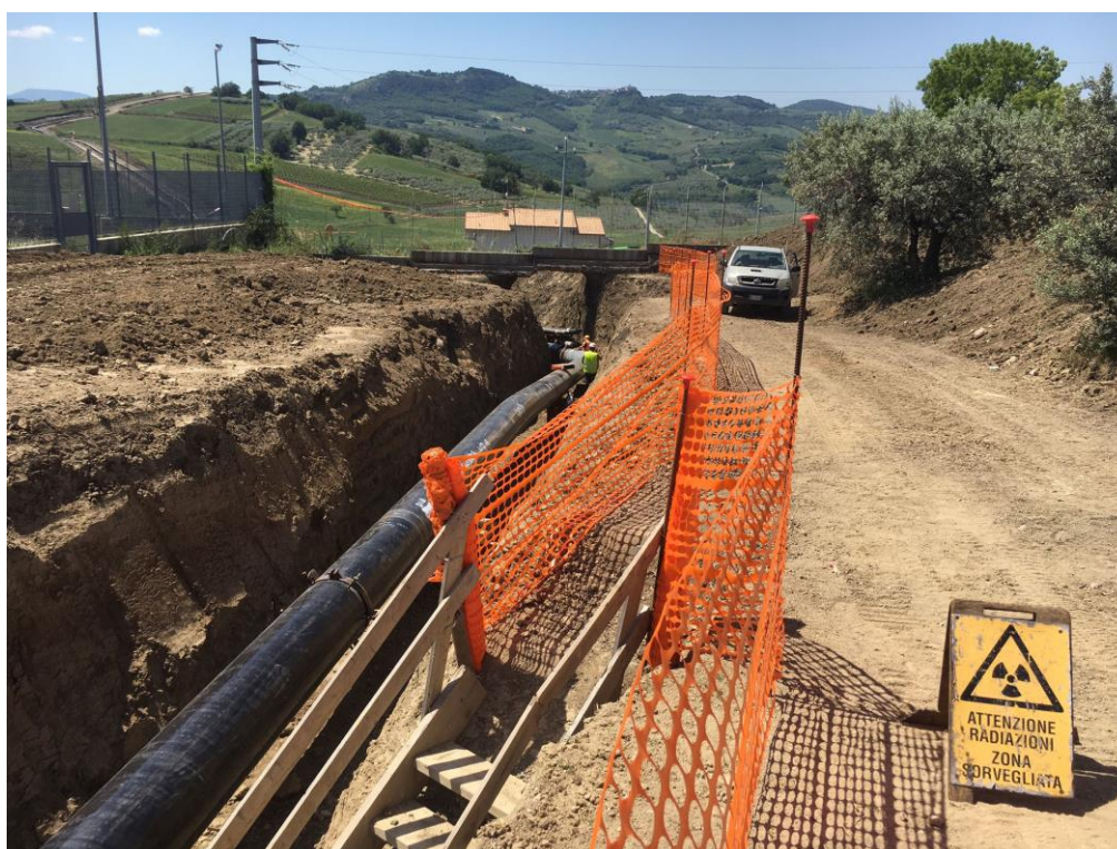
Fig. 1 – Cartello di segnalazione del tipo di zona, apposto durante l'esecuzione dei controlli con radiografie
