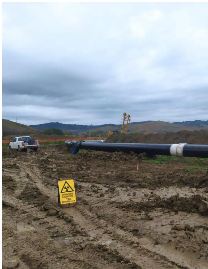
Fig. 1 – Cartello di segnalazione del tipo di zona, apposto durante l'esecuzione dei controlli con radiografie
