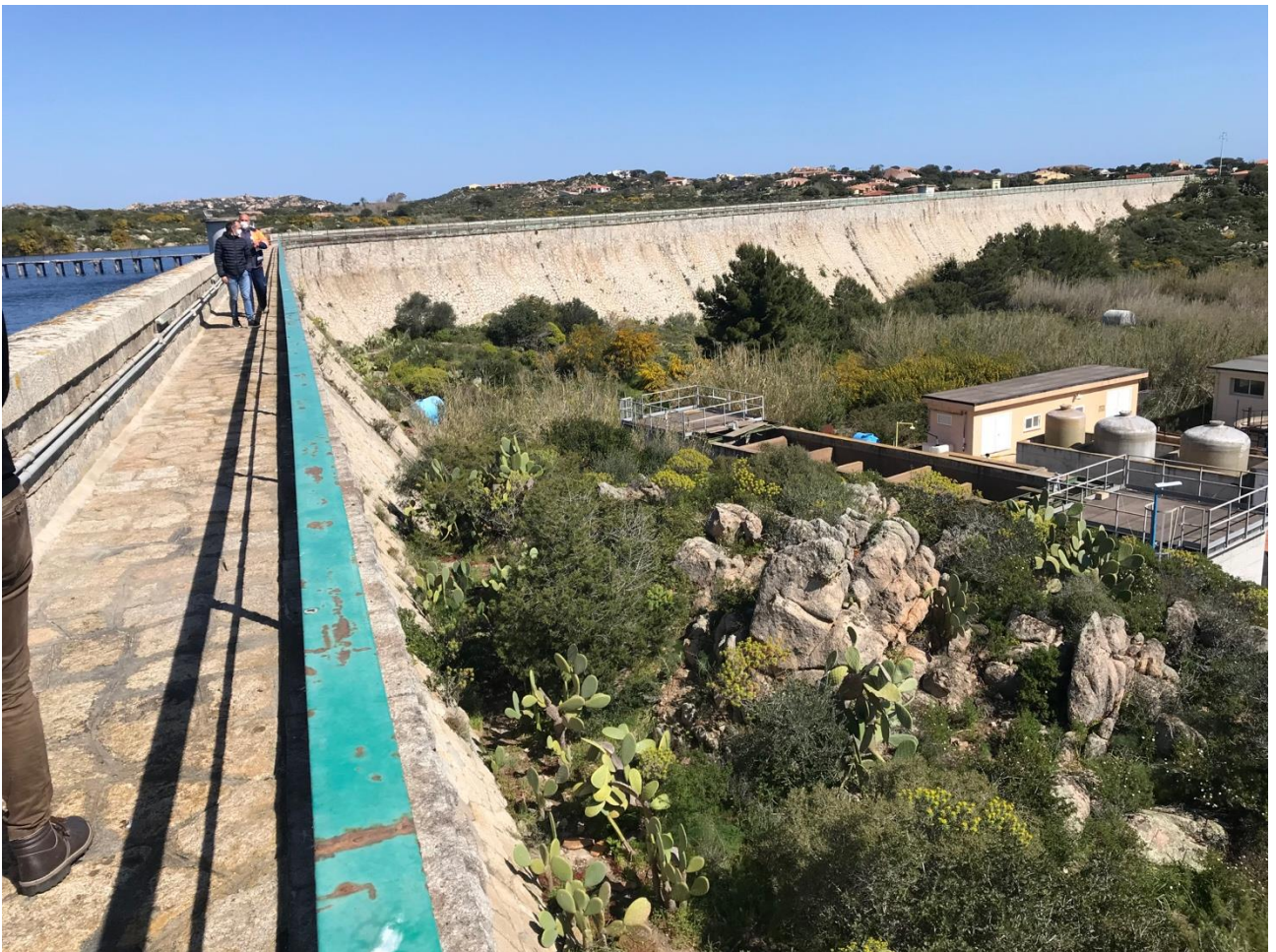
Figura 3 – Diga Puzzeni – Paramento di valle
