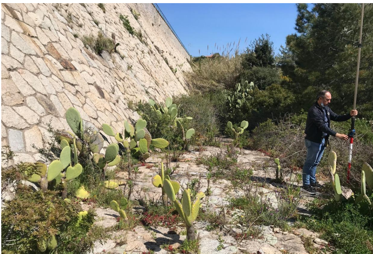
Figura 6 – Zoccolo di fondazione del paramento di valle
