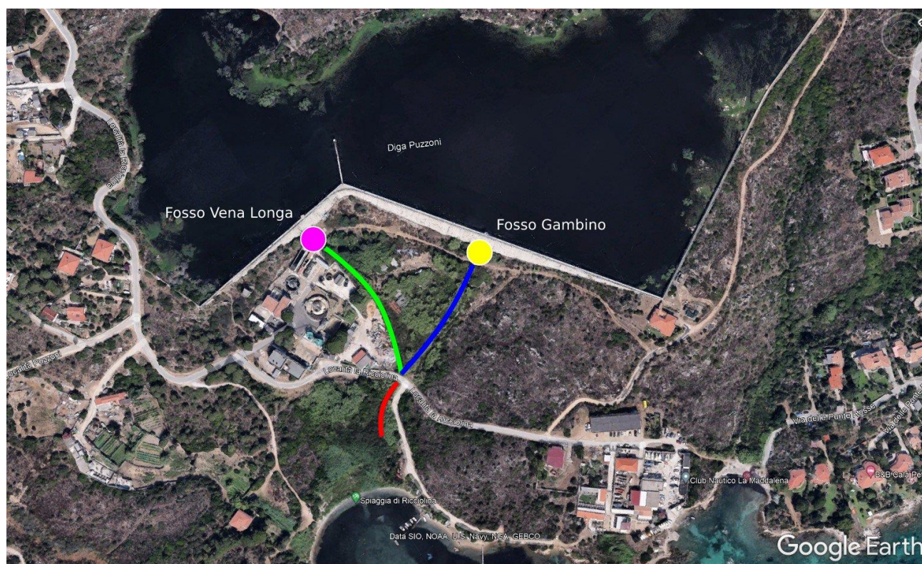
Figura 9 – Canali fuggatori (Fonte: Sardegna Mappe)
