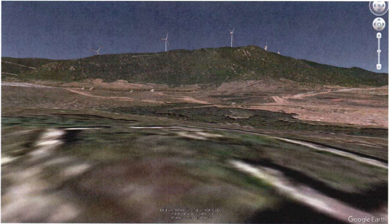
(da Google Earth – “Modello 3D progetto” trasmesso da ECOWIND 2 S.r.l. – ripreso dal sito dei ruderi della chiesa romanica di S. Barbara di Solanas)
