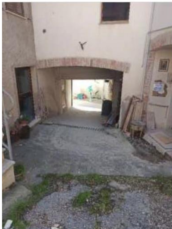
Figura 5: Ripresa fotografica del punto critico segnalato dalla Regione.
