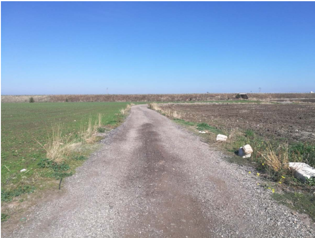
Figura 30: Percorso elettrodotto interrato MT di connessione alla rete – USCITA T.O.C.
