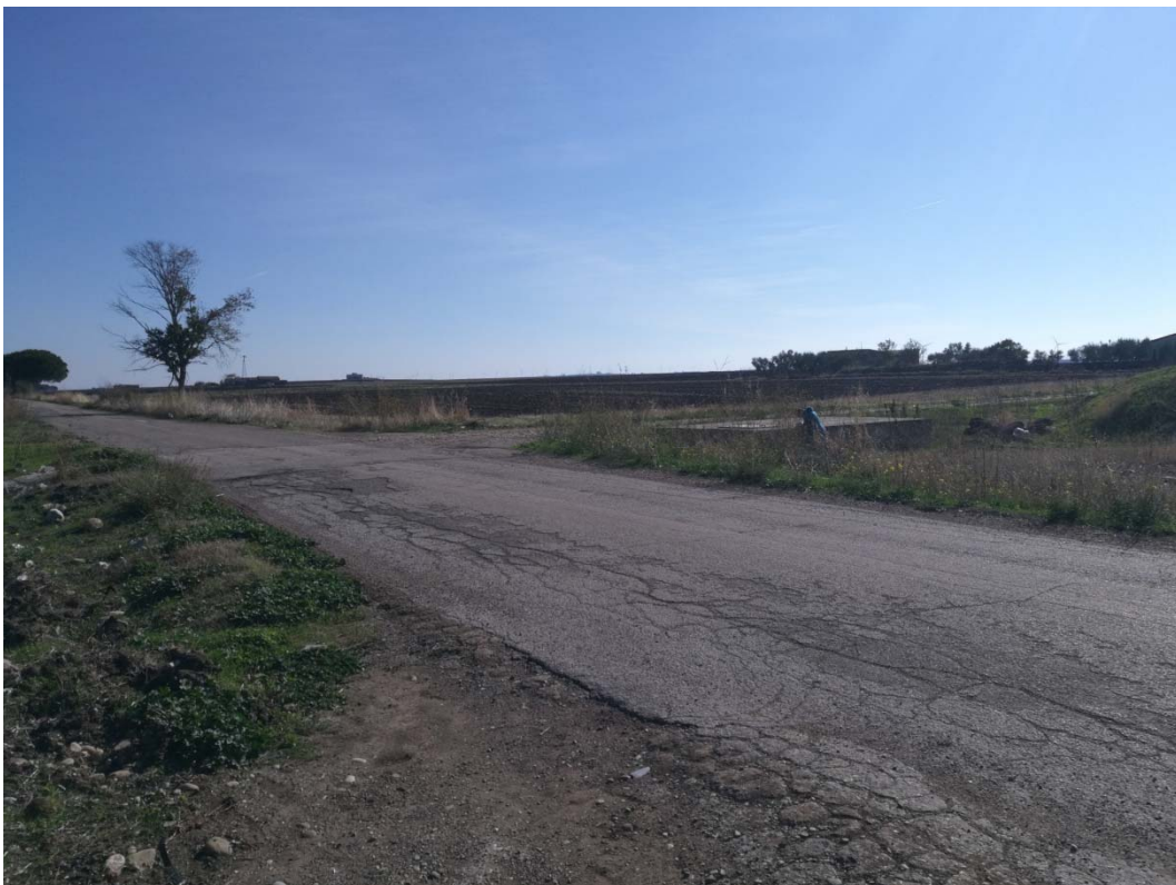
Figura 29: S.P. N. 77 – Attraversamento in T.O.C.
