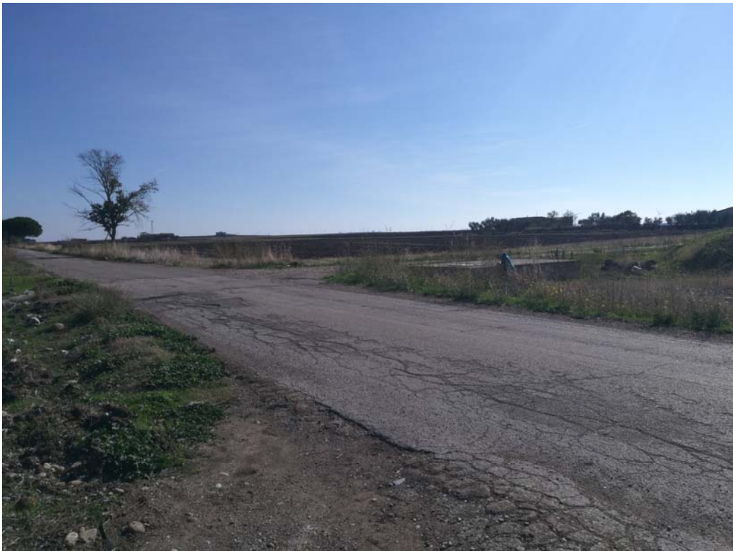
Figura 78: S.P. N. 77 – Attraversamento in T.O.C.
