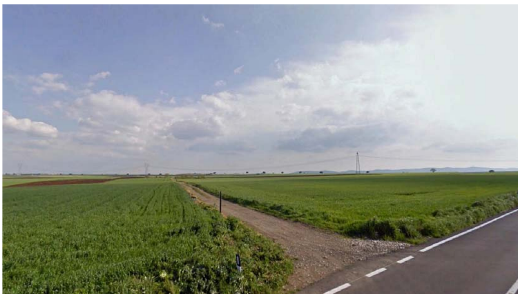
Figura 82: Vista da S.P. Montemilone – Venosa – Area accesso Sottostazione Utente e RTN Terna
