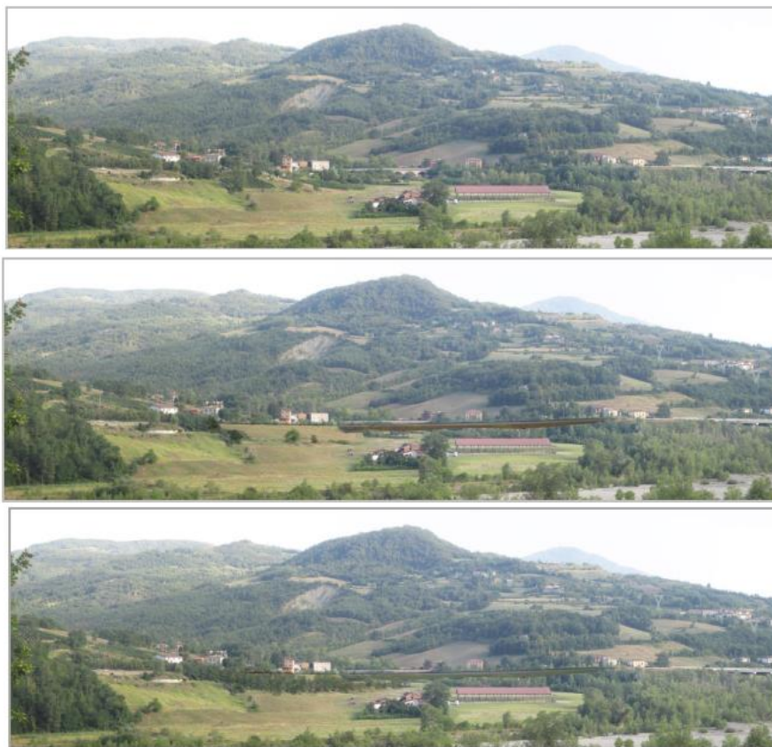
Figura 16 – Viadotto Cernusca – stato attuale, struttura in Corten, integrazione progettuale con struttura in acciaio verniciato RAL 6017 ed estensione delle opere di sistemazione a verde lungo il tratto in rilevato
