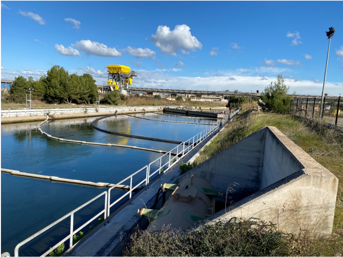
Figura 18 – Vista del 2° Canale ILVA in corrispondenza tratto terminale
