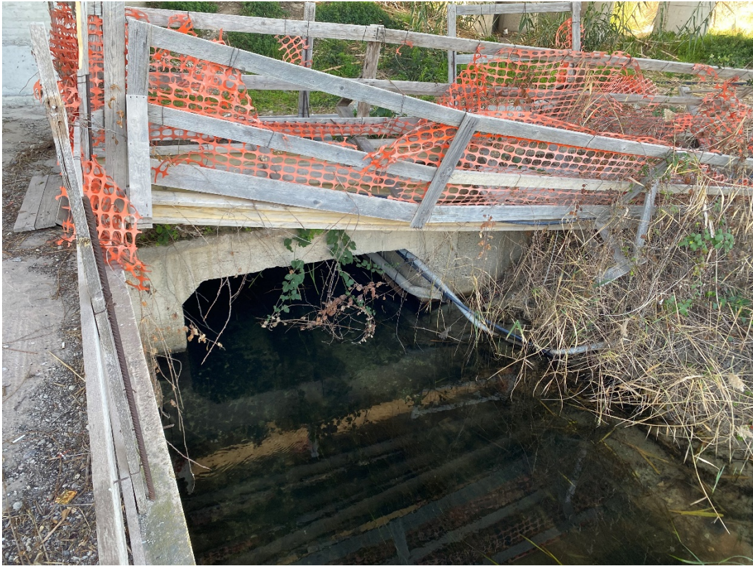
Figura 15 – Tombino ferroviario a valle dell'attraversamento della Strada dei Moli
