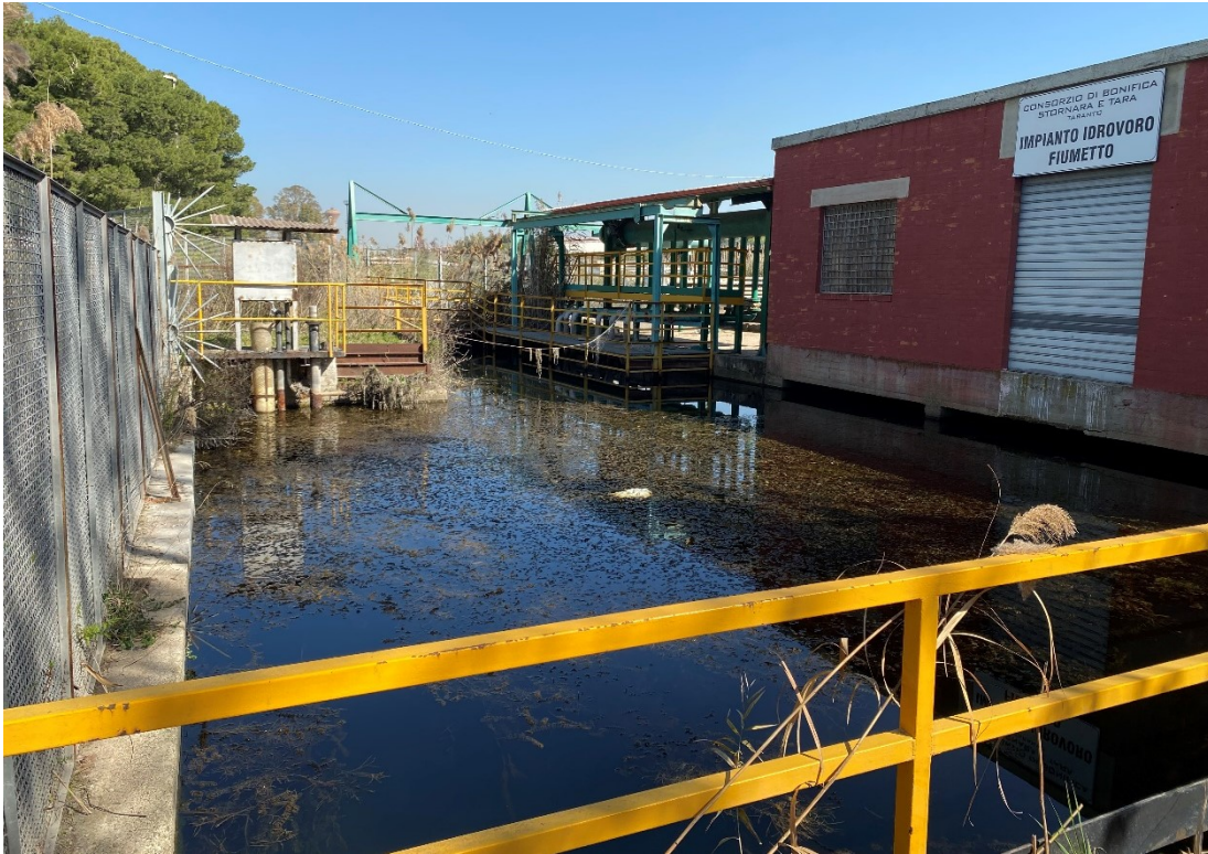
Figura 13 – Idrovora fiumetto e relativa vasca canale
