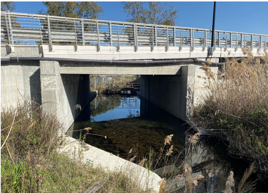
Figura 14 – Attraversamento di recente realizzazione della Strada dei Moli a valle dell'Idrovora Fiumetto
