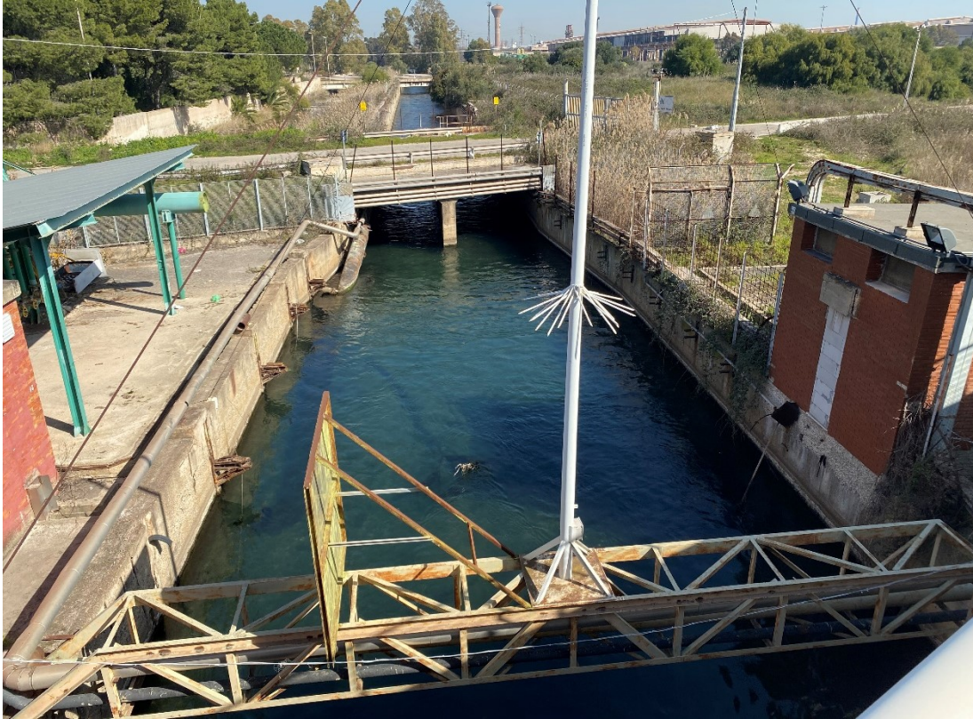
Figura 17 – Vista del 2° Canale ILVA in corrispondenza dell'Idrovora Fiumetto
