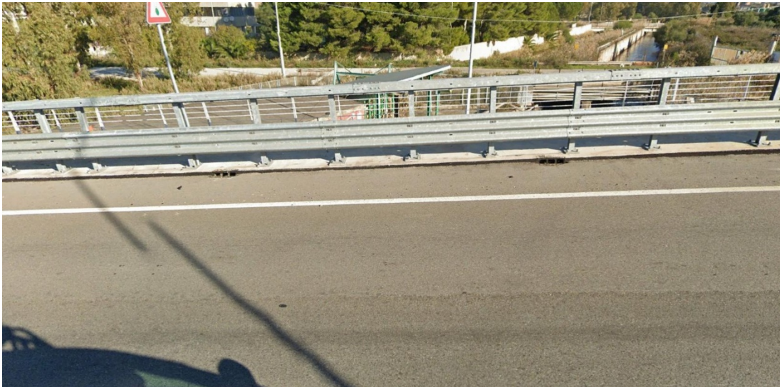
Figura 19 – Vista dalla SS 106 2° Canale ILVA in corrispondenza dell'idrovora di Fiumetto
