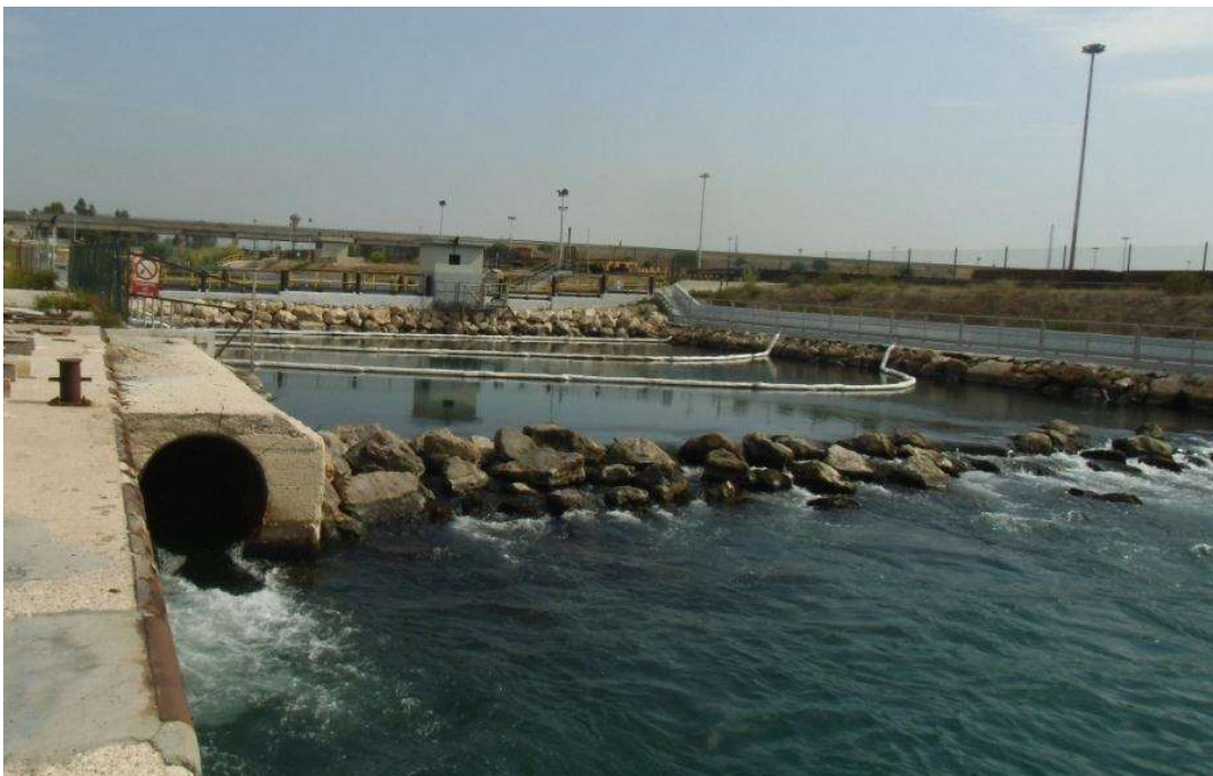
Figura 16 – Scarico a mare del Canale Fiumetto (tubazione a sx) e del 2° Canale ILVA (scogliera a dx)
