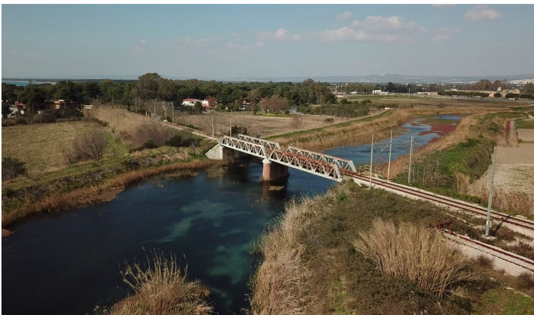
Figura 9 – Attraversamento ferroviario Taranto-Reggio Calabria
