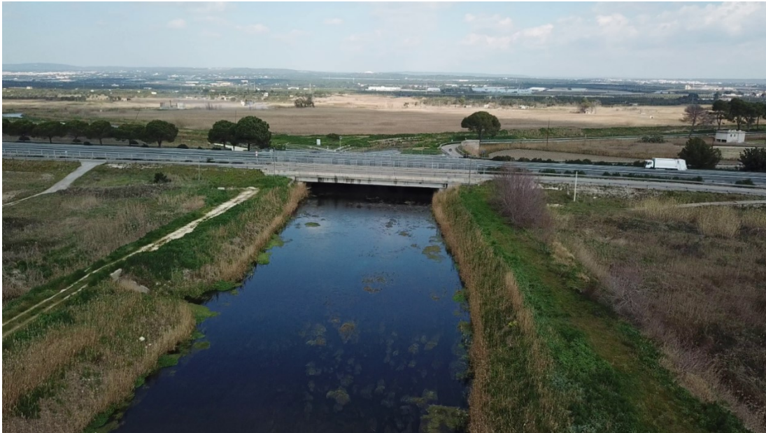
Figura 10 – Attraversamento Strada Statale 106 Jonica e sue complanari.
