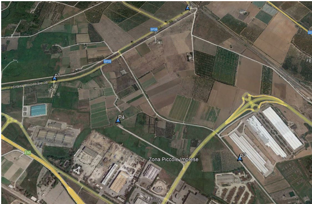
Figura 6: vista dei punti di misura
